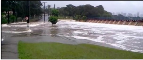
Figura 12 – Inundação da rua Almeida Garret que passa na barragem
