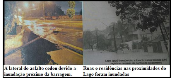
Figura 13 – Danos causados pelas inundações de 2011
