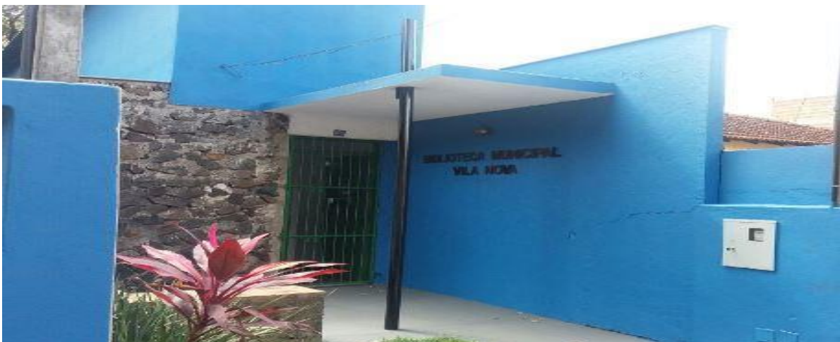
Figura 7 - Fachada do prédio da Biblioteca Ramal Vila Nova “Padre Adelino de Carli”
