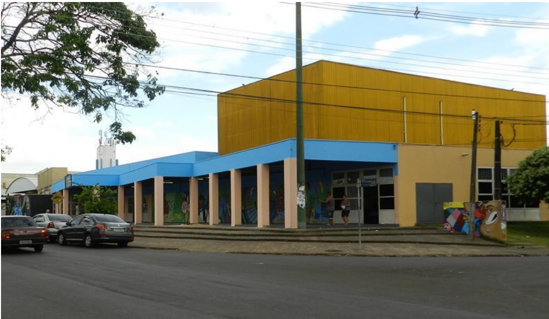
Figuras 9 - Fachada do prédio da Biblioteca Ramal “Lupércio Luppi”
