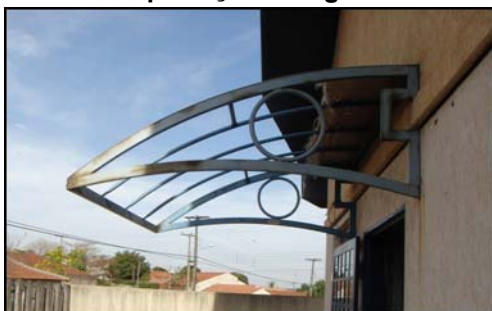
Figura 82 - Toldo de proteção
