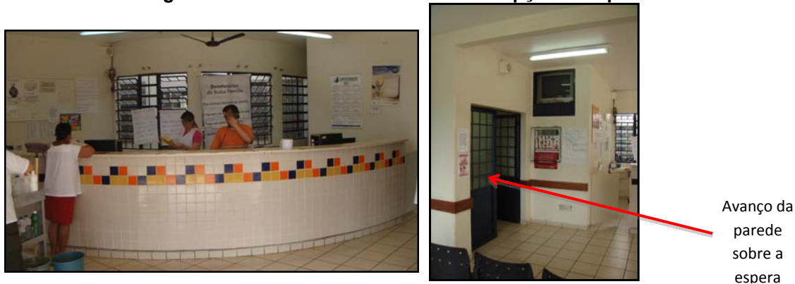
Figura 62 - Balcão de atendimento e recepção UBS β
