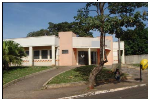
Figura 60 - Vista frontal da UBS β
