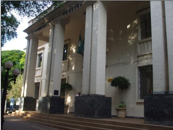
Figura 8 – Fachada da atual Biblioteca Pública Municipal, antigo Fórum.
