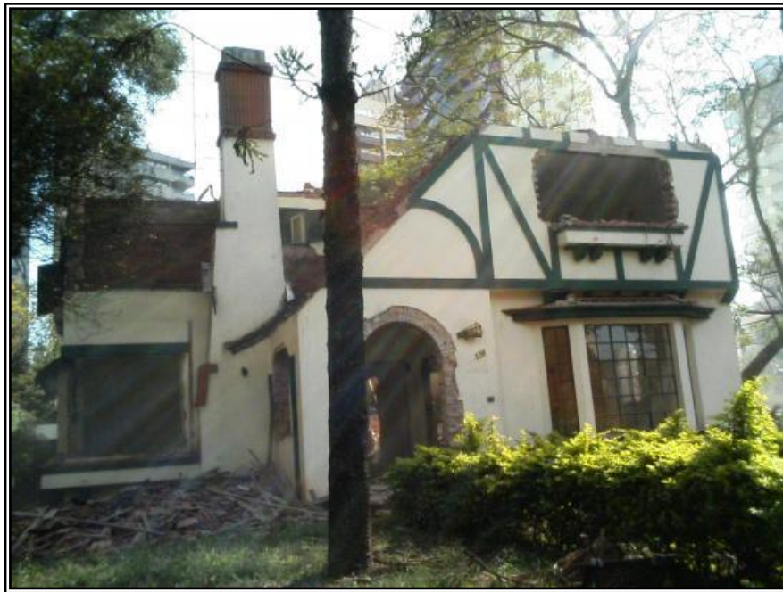
Figura 2 – Demolição da “casa dos gnomos”.
