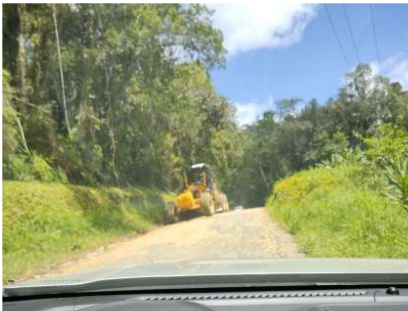
Figura 2 – Máquina fazendo a manutenção da rodovia
