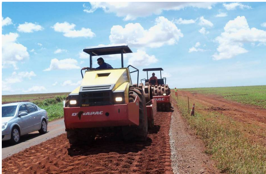
Figura 8 – Execução de estabilização de solo com cimento Portland nas obras para adequação da BR-163/PR no seguimento entre Guaíra e Mercedes no km 326.
