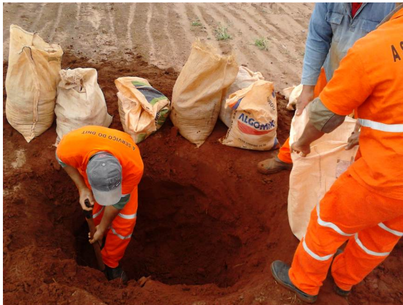
Figura 17 – Escavação de solo para experimentação.
