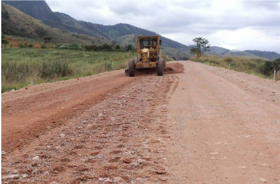
Figura 7 – Execução de estabilização granulométrica do solo nas obras de implantação da LMG-650/MG no seguimento entre Medina e Comercinho no km 26.
