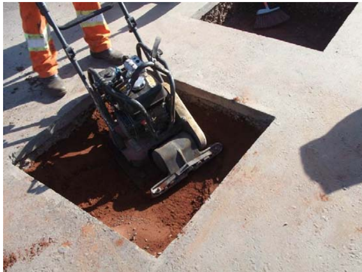
Figura 38 – Compactação realizada nos ensaios de campo.
