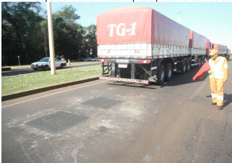
Figura 40 – Capa de rolamento recomposta para o ensaio de campo.
