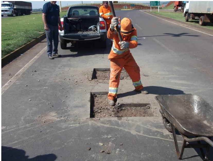
Figura 32 – Retirada do revestimento em camada concreto betuminoso para execução do ensaio de campo.
