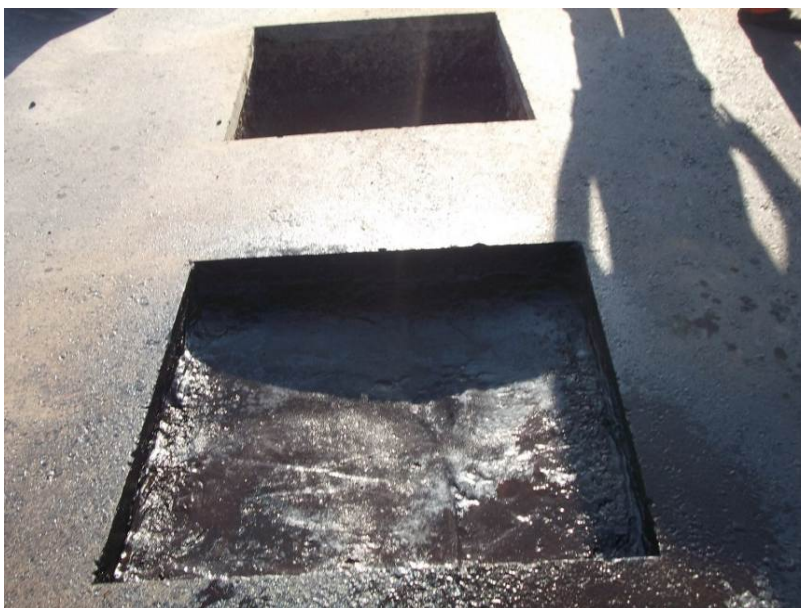
Figura 39 – Imprimação de base em ensaios de campo.
