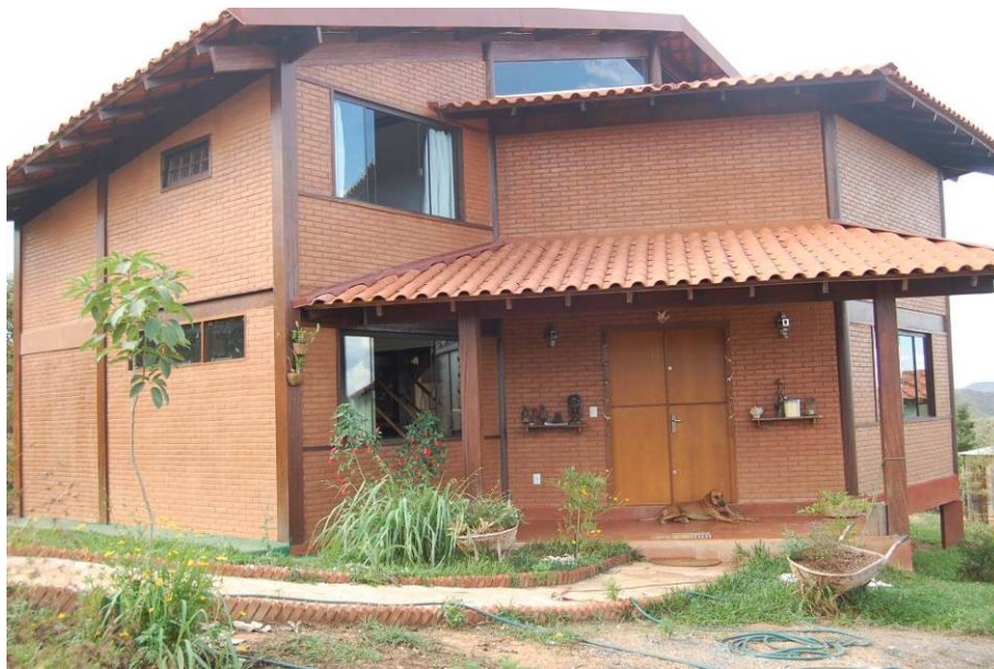
Figura 9 – Construção de habitação com blocos de solo-cimento.
