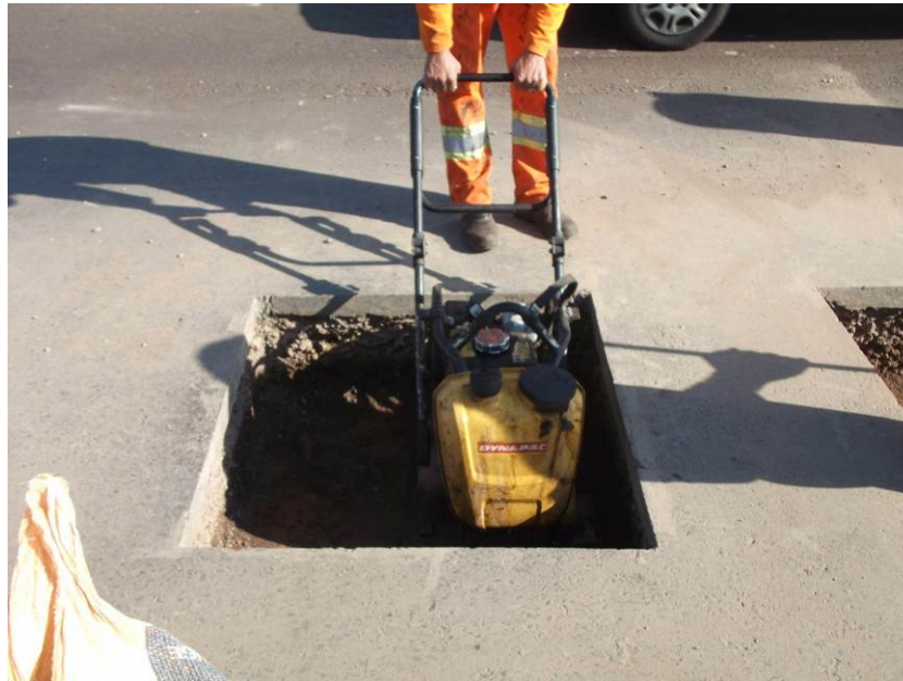
Figura 35 – Compactação das cavas em ensaio de campo.
