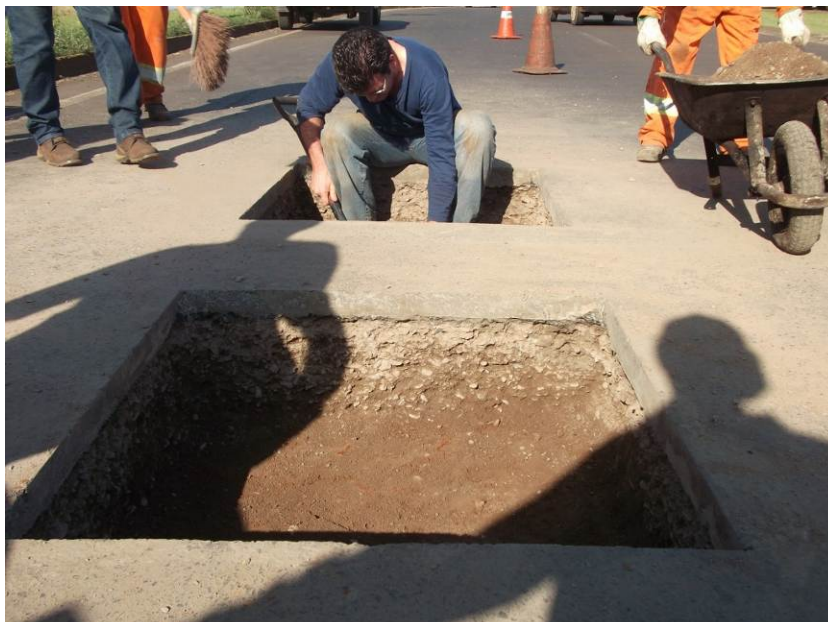
Figura 34 – Arremates nas cavas dos locais para os ensaios de campo.
