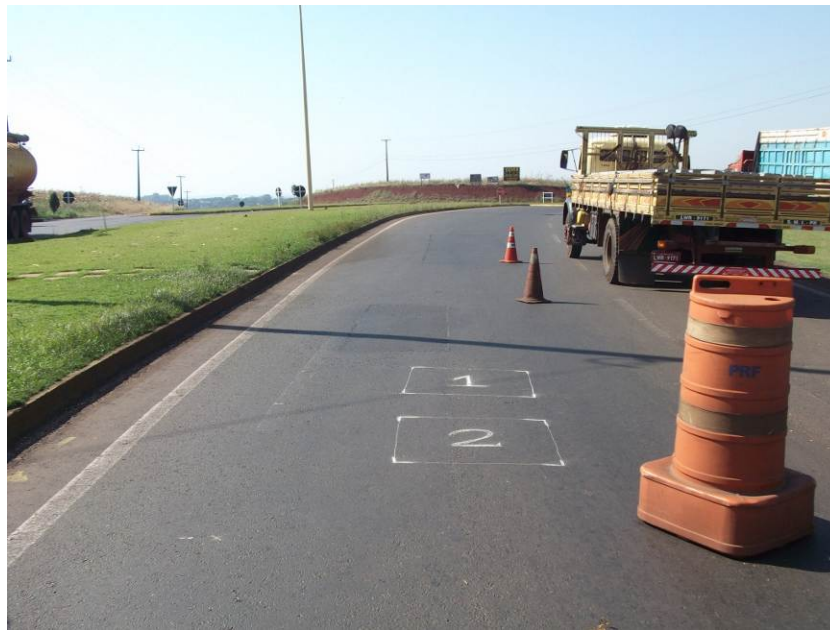
Figura 29 – Demarcação dos locais onde foram realizados os ensaios de campo, BR-163/PR km 276.
