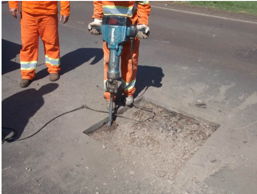
Figura 33 – Retirada da base antiga em ensaio de campo.
