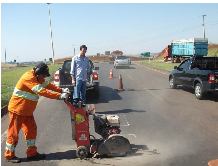
Figura 31 – Corte do revestimento betuminoso para realização do remendo experimental em campo.
