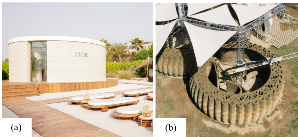
Figura 18. (a) Loja impressa da Dior composta por dois módulos circulares, localizada na praia de Jumeirah, em Dubai. (b) Habitat Tecla com construções sustentáveis de 50 m 2 executadas por várias impressoras 3D com 200 horas de impressão e 150 km de extensão, localizada em Ravenna, na Itália. Fonte: Wasp, 2022.
