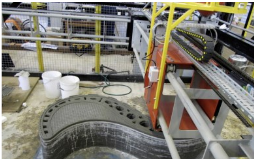
Figura 8 – Impressão 3D no método Concrete Printing
