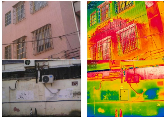
Figura 39 -Imagem térmica de edificações
