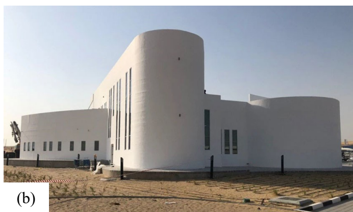
Figura 13. (a) Edificação em processo de execução localizada em Dubai. Fonte: Apis Cor. (b) Edificação concluída. Fonte: 3D natives.
