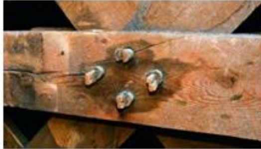
Figura 12 - Ligação com cavilha no sótão do Tabernáculo de Salt Lake
