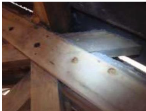
Figura 13 - Ligação com cavilha em Galpão para armazenagem de produtos químicos em São Paulo (Brasil)
