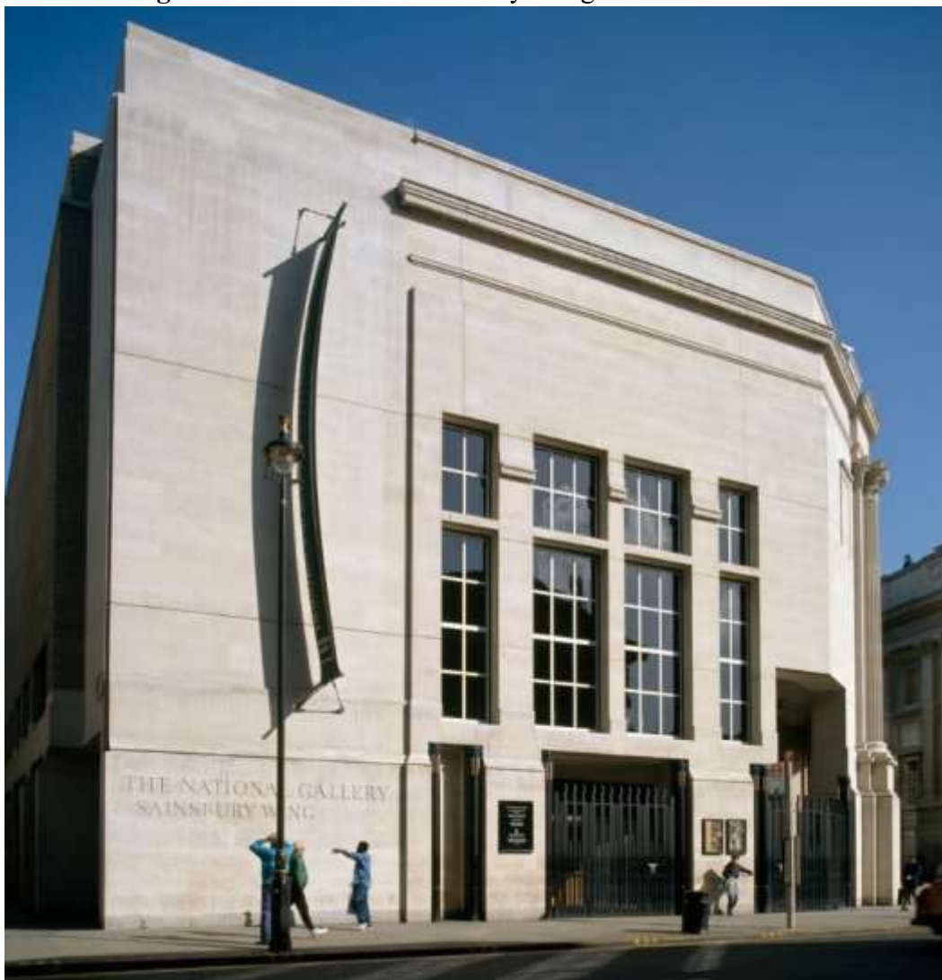
Figura 24 – Entrada da Sainsbury Wing antes da reforma
