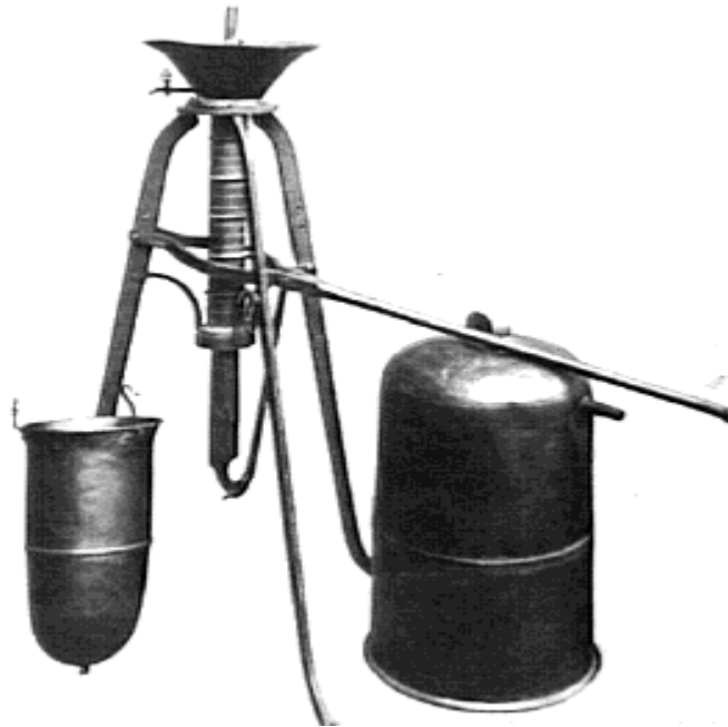
Figura 6. Bomba construída por Otto Von Guericke (pp. geocities , 2017)
