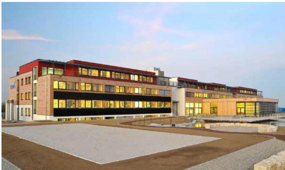
Figura 20. Edificação construída com CLT. Fonte: FPIinnovations (2011) CLT Handbook .
