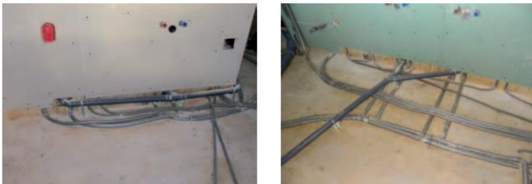
Figura 14. Instalações elétricas e hidráulicas sem rasgos no Painel. Fonte: KLH Massivholz GmbH (2011) Component Catalogue for CLT Structures.
