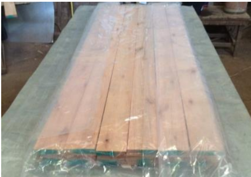
Figura 44. Preparação para prensagem do Painel CLT. Fonte: autor.
