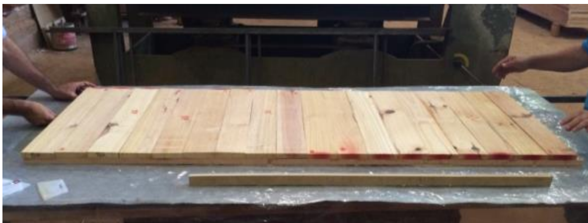
Figura 41. Montagem do Painel CLT. Fonte: autor.
