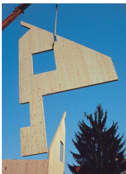
Figura 17. Transporte dos Painéis CLT. Fonte: Finnforest Merk GmbH (2010) .
