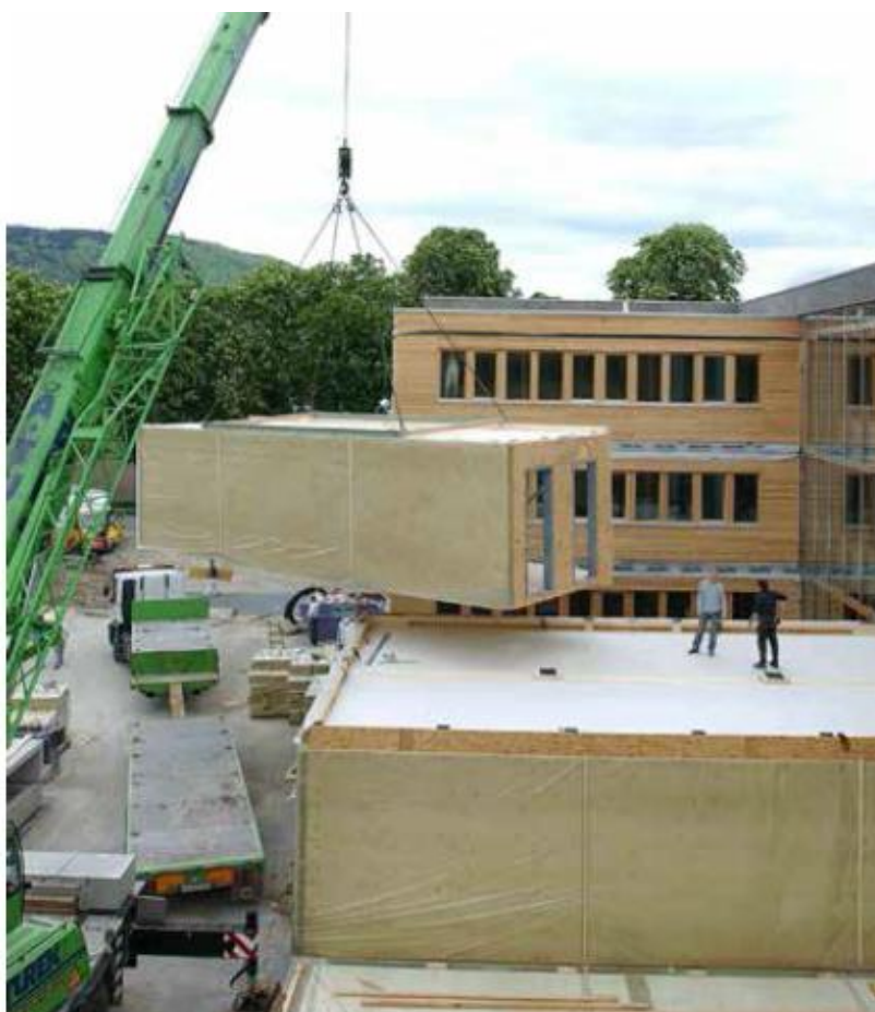
Figura 18. Transporte de blocos pré-fabricados com CLT. Fonte: FPInnovations (2011) CLT Handbook .
