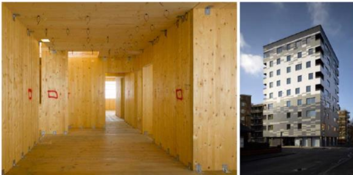
Figura 23. Edifício Stadthaus em Londres: Vista interna durante a construção e vista externa do edifício acabado. Fonte: http://www.waughthistleton.com
