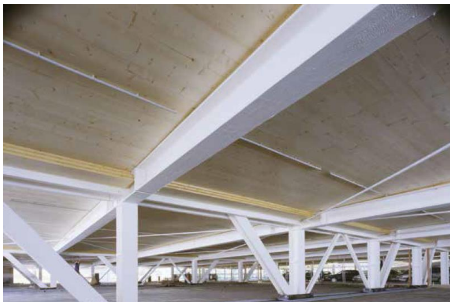
Figura 22. Laje de cobertura executada em CLT. Fonte: FPIInnovations (2011) CLT Handbook .
