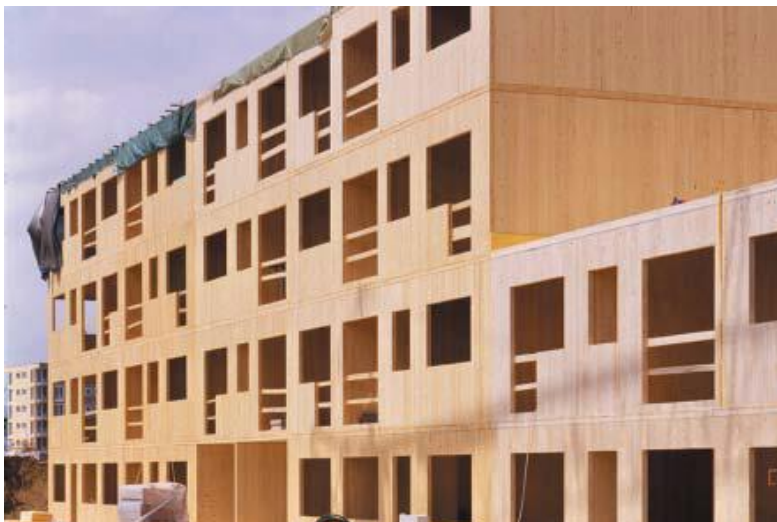
Figura 19. Construção utilizando painéis CLT. Fonte: FPIinnovations (2011) CLT Handbook .
