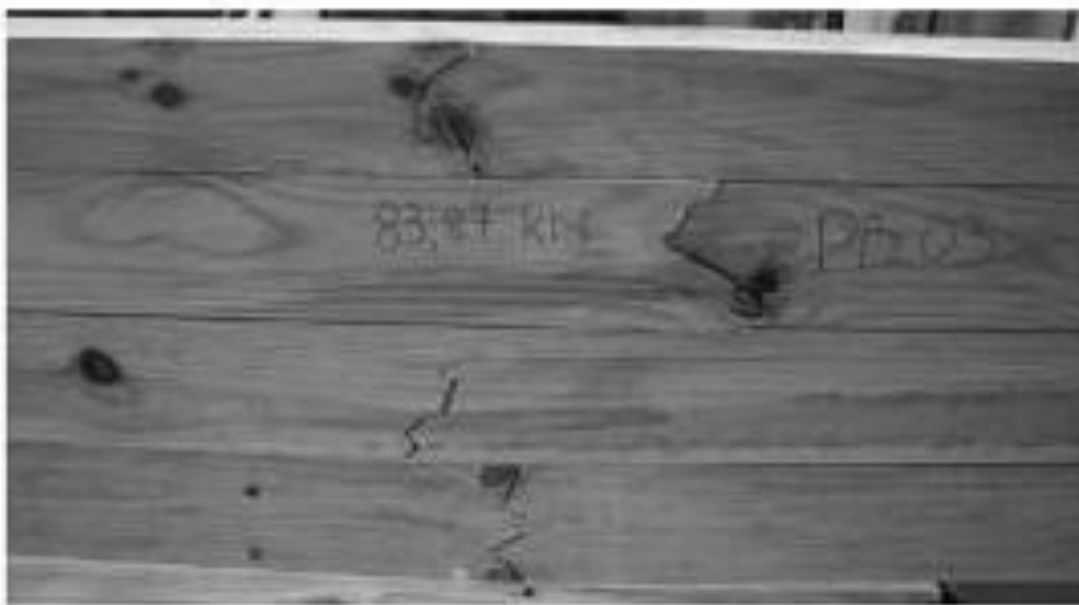
Figura 26. Ruptura do painel CLT no alinhamento dos nós. Fonte: CONCU et al (2013).
