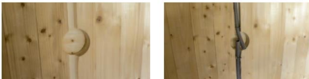
Figura 13. Instalações elétricas através de rasgos no Painel. Fonte: KLH Massivholz GmbH (2011) Component Catalogue for CLT Structures .
