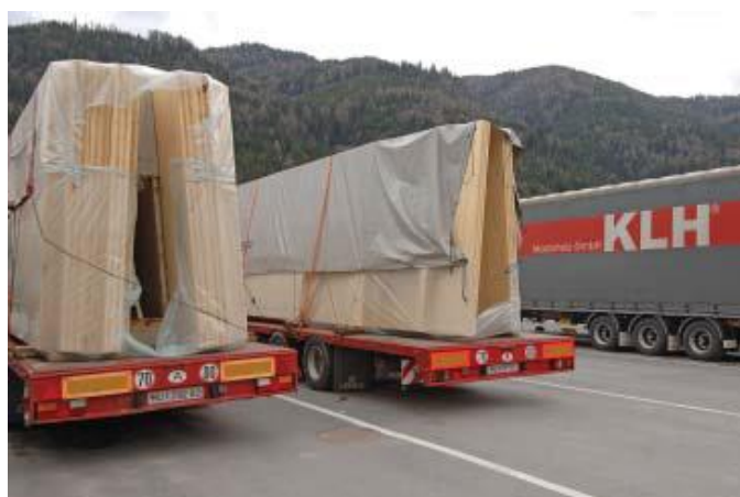
Figura 16. Transporte dos Painéis CLT. Fonte: FPInnovations (2011) CLT Handbook .
