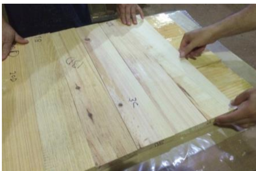
Figura 42. Montagem do Painel CLT. Fonte: autor.
