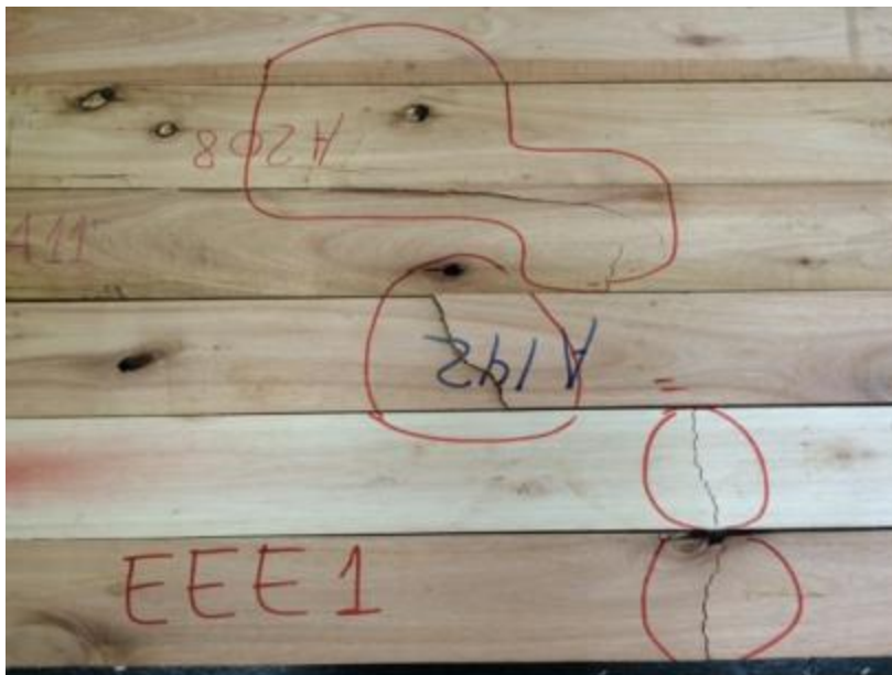
Figura 72. Painel EEE grupo 1. Fonte: autor.
