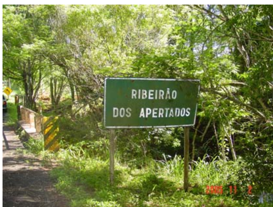
Ponte sobre o Ribeirão dos Apertados.
