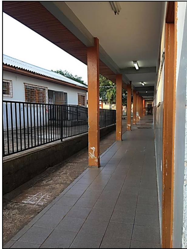
Figura 06 - Pavilhão em alvenaria.
