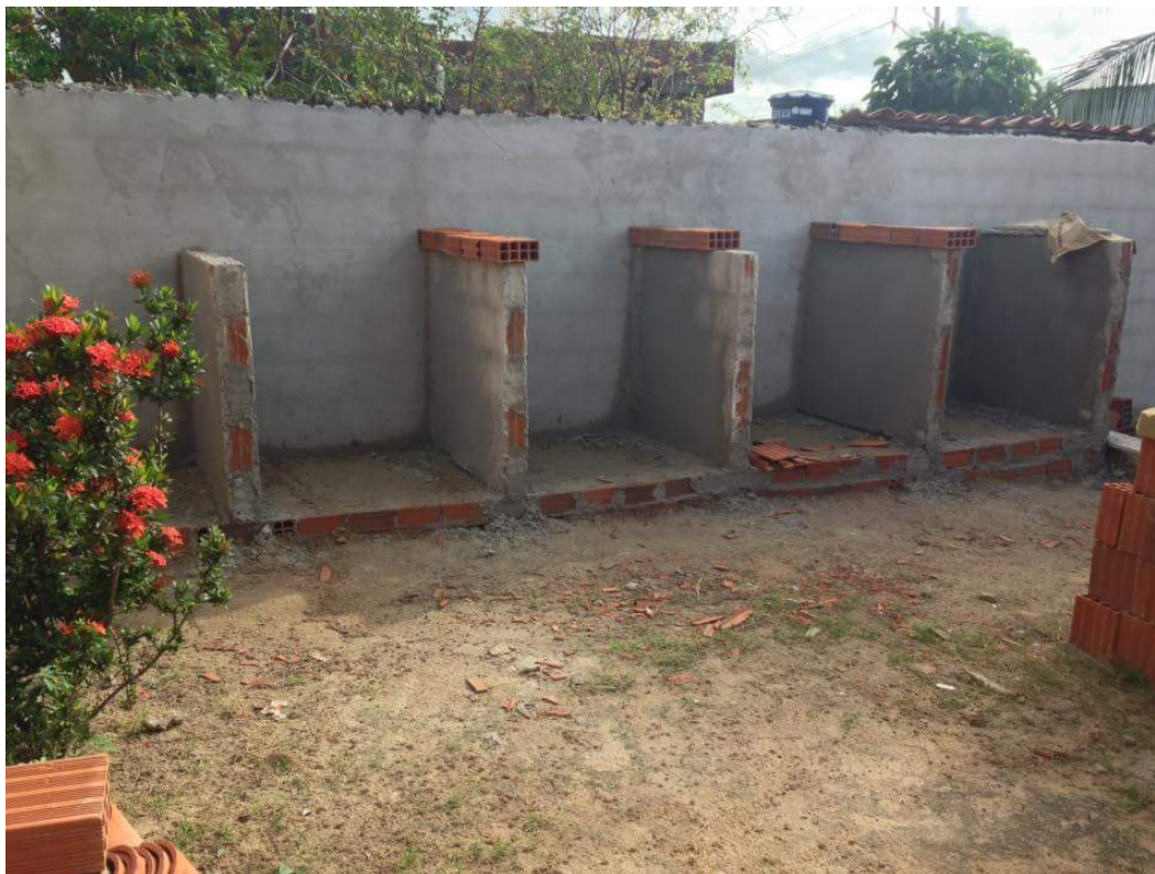
Figura 4 - Início da construção dos canis na sede definitiva da ONG LAT
