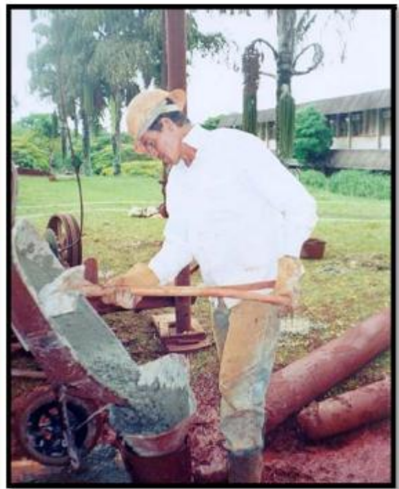
Figura 2.21 – Concretagem da estaca
