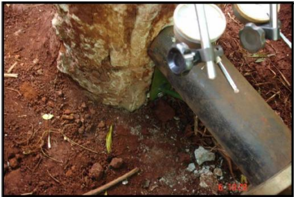
Figura 4.12 – Detalhe do cano sobre o suporte
