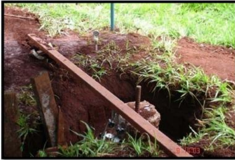
Figura 5.7 – Estaca S6 e tensiômetro instalado
