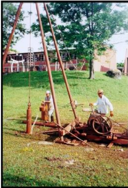
Figura 2.18 – Escavação com pilão
