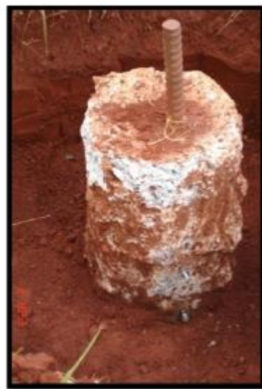
Figura 4.8 – Chumbadores instalados
