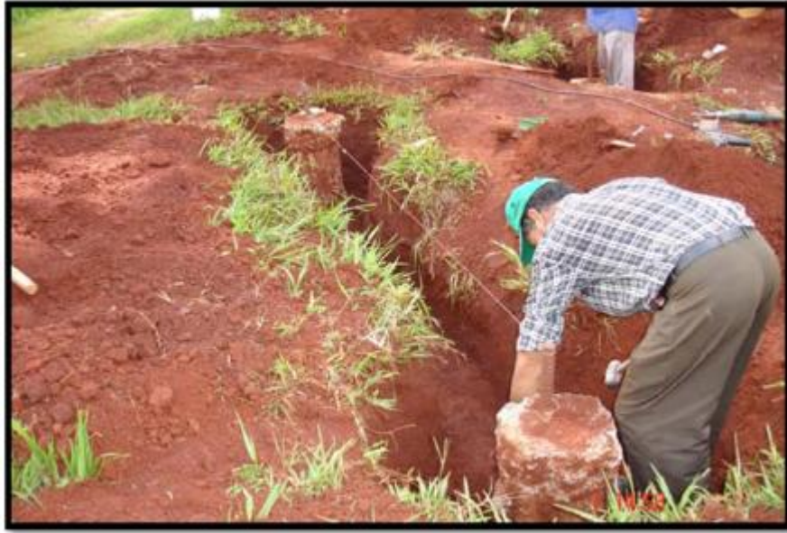
Figura 4.6 – Alinhamento sendo realizado para a fixação do suporte nas estacas
