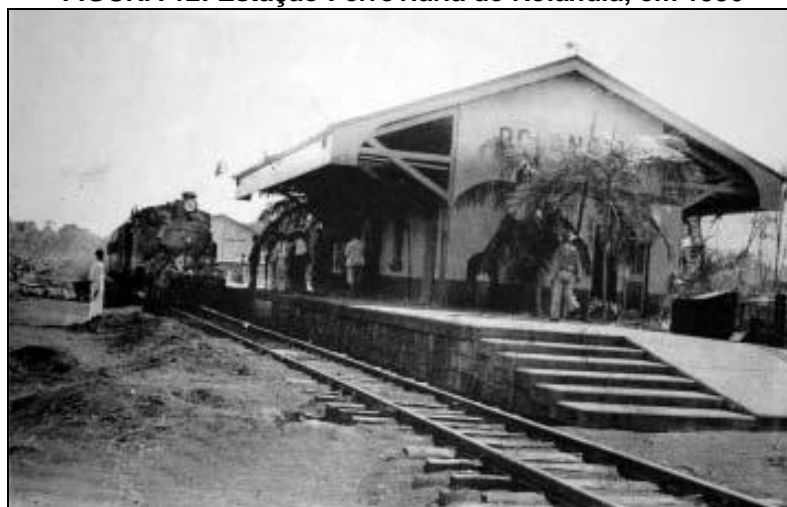
FIGURA 12: Estação Ferroviária de Rolândia, em 1936
