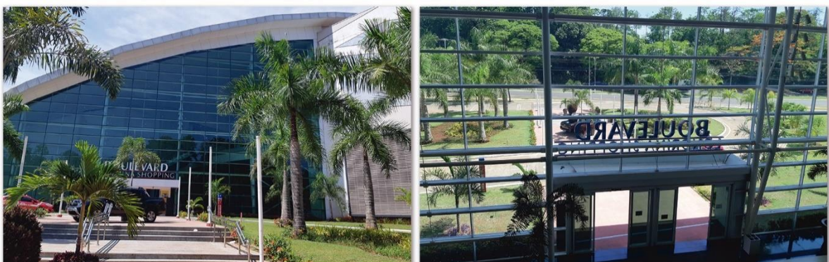
Figuras 39 e 40 – Entrada de pedestres para o hall principal
