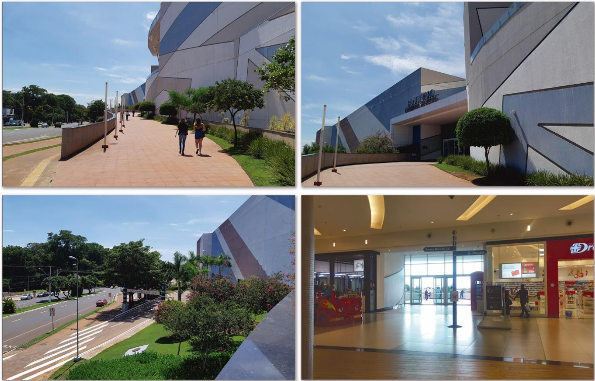
Figuras 41, 42, 43 e 44 – entrada de pedestres próxima à Avenida Dez de Dezembro
