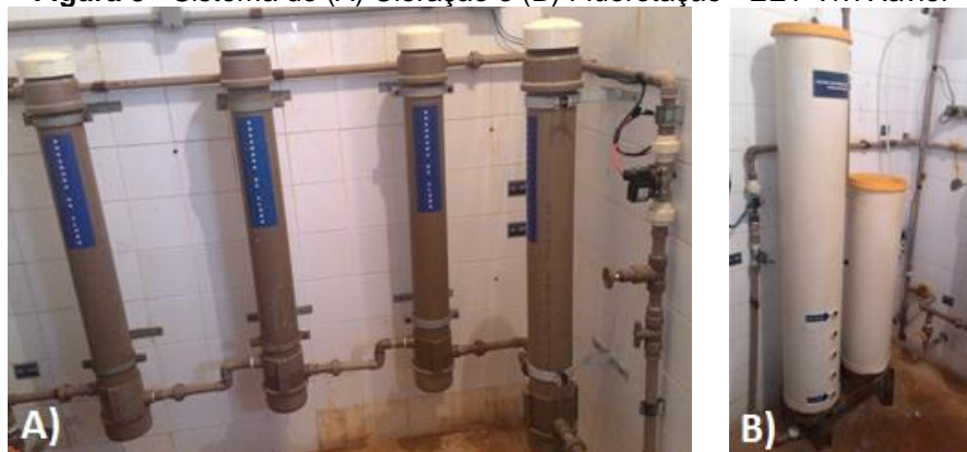
Figura 5 - Sistema de (A) Cloração e (B) Fluoretação - EET Vivi Xavier
