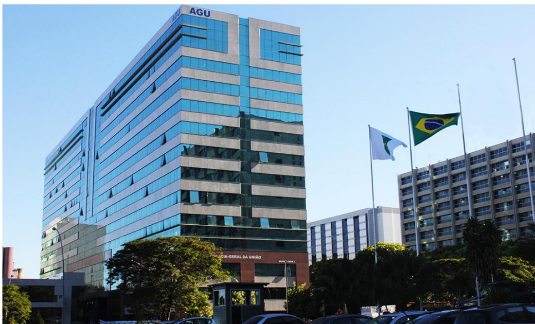
Figura 6 - Edifício sede da Advocacia-Geral da União.
