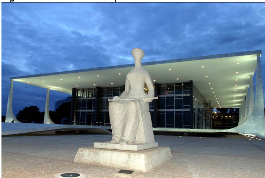
Figura 1- Edifício sede do Supremo Tribunal Federal
