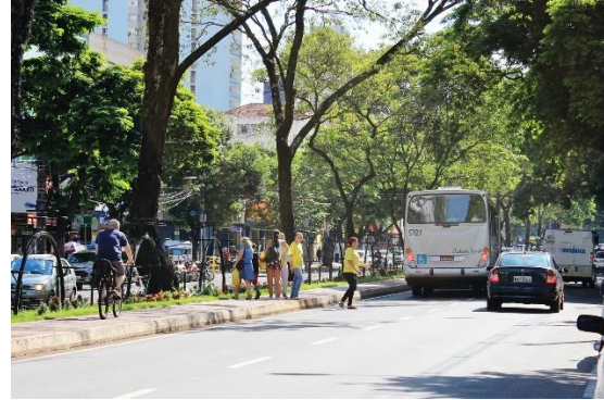
Figura 29 - Avenida Brasil 15 de março de 2017. Trecho irregular de cruzamento da via.
