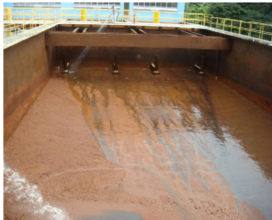
Figura 14 – Remoção final do lodo acumulado no decantador por jateamento
