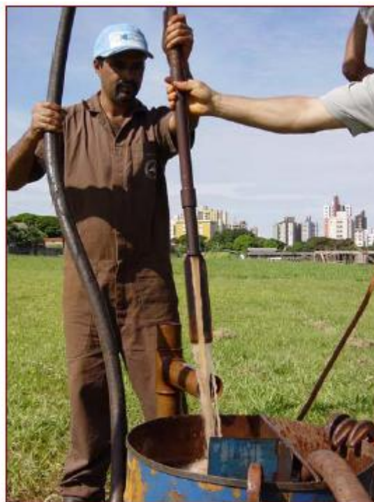
Figura 6 – Trépano com circulação d'água, Belincanta (2004).
