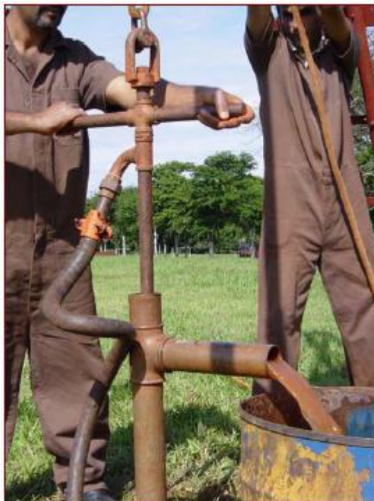
Figura 7 – Procedimento de perfuração com uso de circulação d'água, moto-bomba e trépano, Belincanta (2004).
