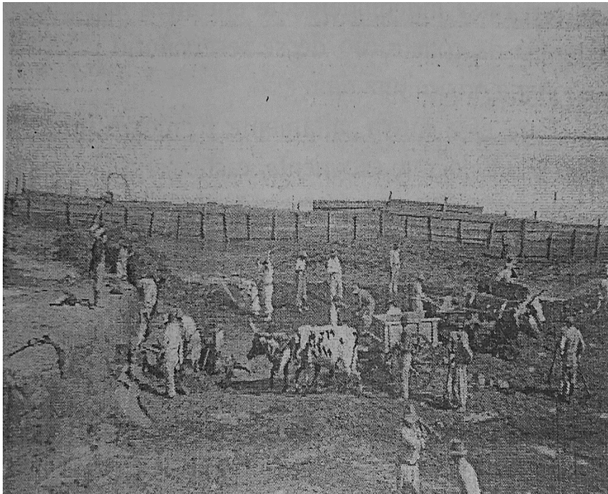
Figura 4.6: Obras de construção da “Barragem Sanchuri”
