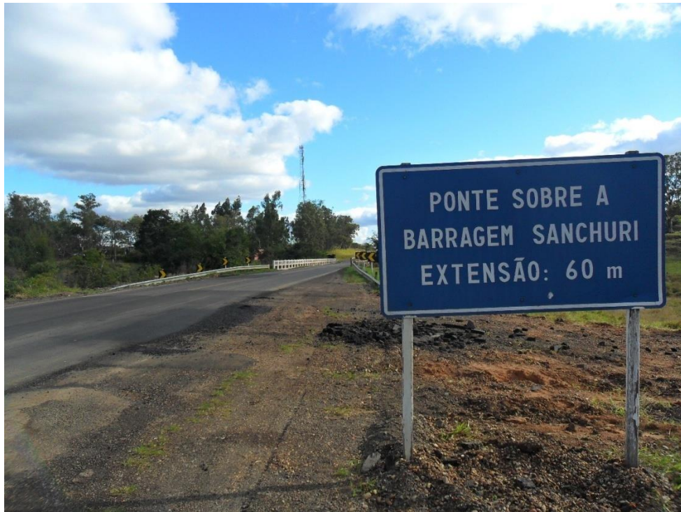
Figura 4.12: Vista da Ponte da BR 272 sobre o vertedouro da “Barragem Sanchuri”.
