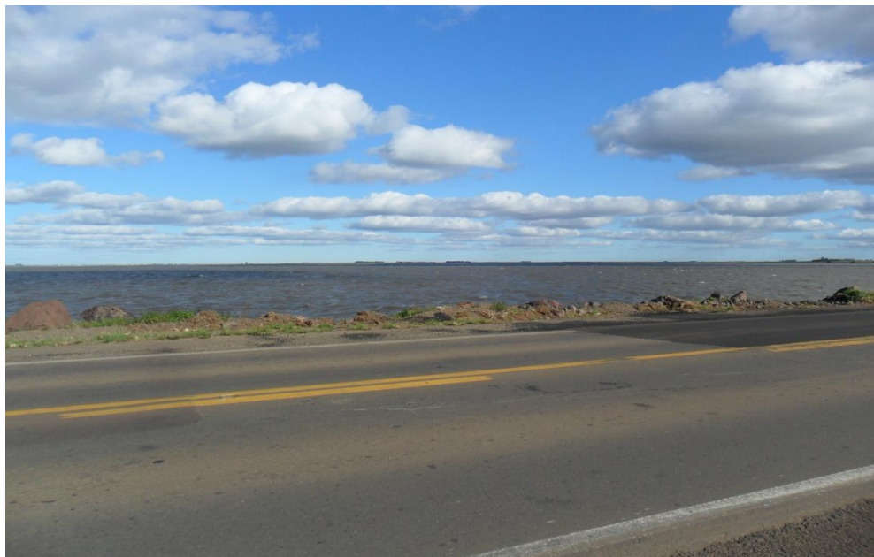
Figura 4.13: Vista parcial da represa da “Barragem Sanchuri” a partir da taipa.
