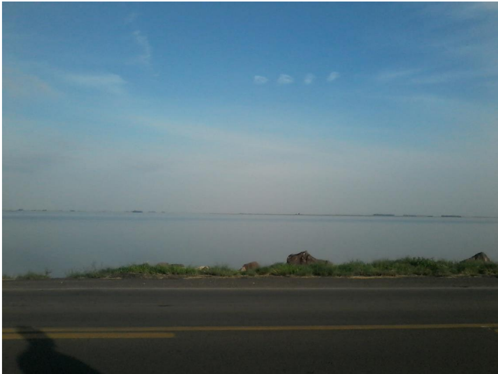
Figura 4.11: Vista parcial da taipa da “Barragem Sanchuri” sobre a BR 272.
