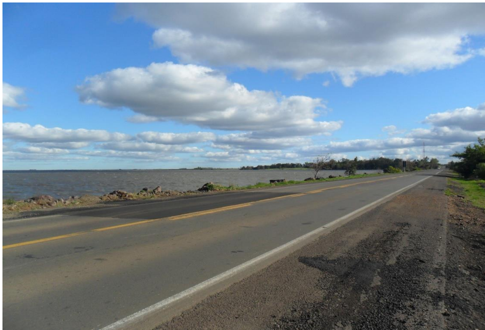
Figura 4.15: Vista parcial da BR 272 que passa sobre a taipa da “Barragem Sanchuri”.
