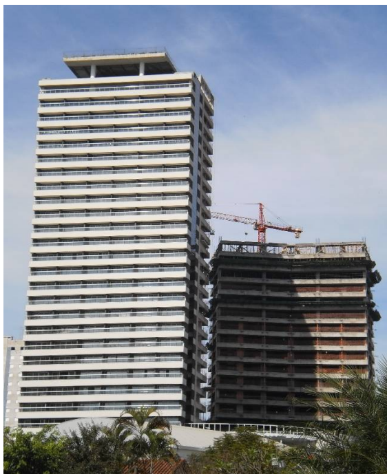
Foto 9 - Vista parcial do Palhano Square Garden. Complexo comercial localizado na Av. Madre Leonia Milito – Gleba Palhano. Empreendimento em construção sob responsabilidade da Vetra Construtora, com área total construída de 30.242,53 m 2 . Fonte: NASCIMENTO, 2014
