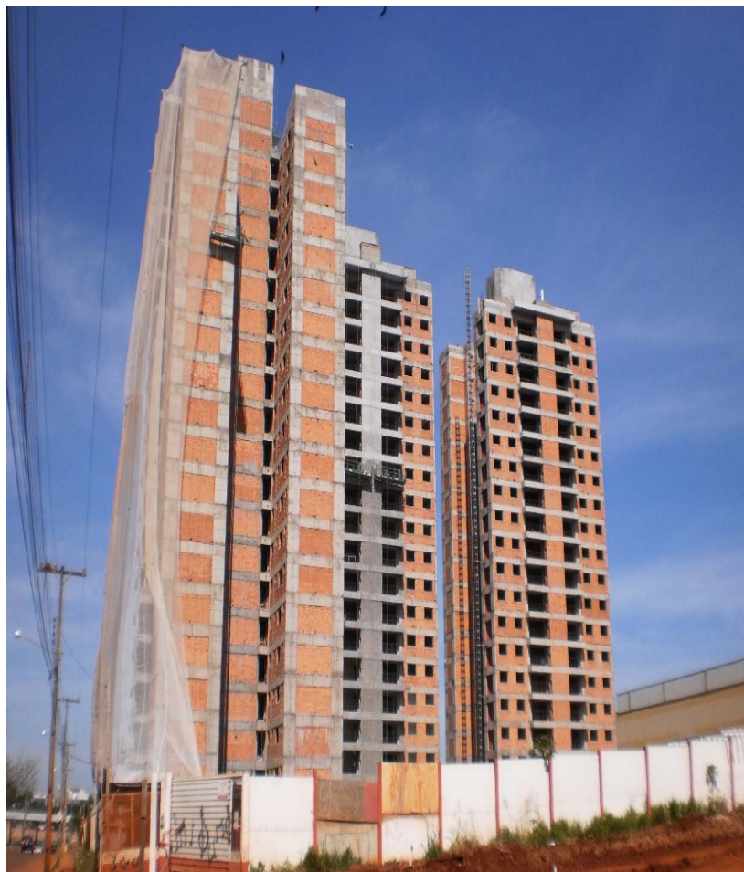
Foto 14 - Vista parcial do empreendimento Vitória Parque localizado na Gleba Palhano. Esse empreendimento está sendo realizado mediante parceria entre a Tha e Rossi Residencial; são três edifícios com 19 pavimentos cada, totalizando 31.582,00 m 2 .
