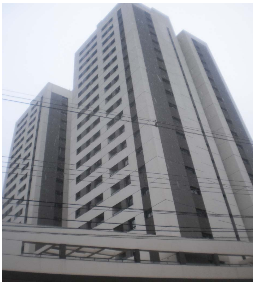
Foto 13 - Vista parcial do Smart City Mayrink Goes. Empreendimento da Bascol Brasil localizado no centro da cidade. São duas torres de 19 pavimentos com apartamentos residenciais e salas comerciais no pavimento térreo, com área total construída de 17.983,77 m 2 .
