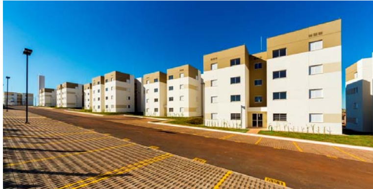
Foto 2 - Vista parcial do Condomínio Vila das Acácias. Entregue no mês de julho/2014, foi construído pela Yticon Construção e Incorporação Ltda., com recursos oriundos do Programa Minha Casa Minha Vida. São 9 torres de 4 pavimentos, totalizando 9.952,64 m 2 .
