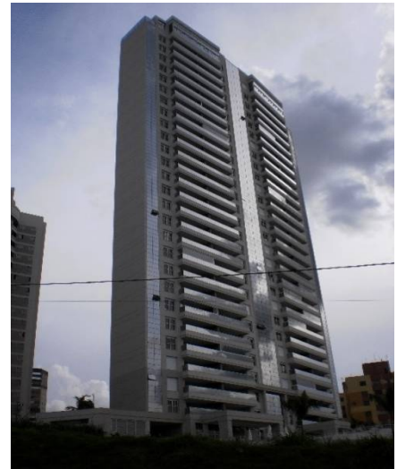
Foto 5 - Vista parcial do Residencial Parc Guell. Empreendimento localizado na Gleba Palhano, em fase final de construção pela Vectra Construtora. São 28 pavimentos, totalizando 26.731,35 m 2 de construção.
