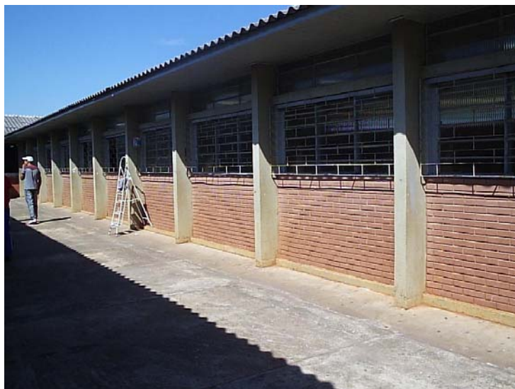
Figura 4 – Beiral com sombreamento nas aberturas do Colégio Estadual Walfredo S. Correa em Arapongas.
