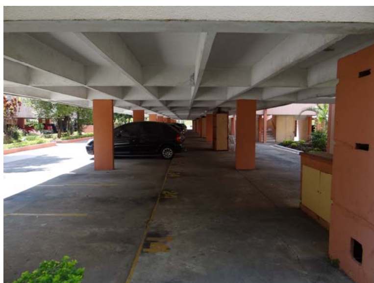
Figura 95 – CECAP Zezinho Magalhães Prado - Guarulhos/SP - Vigas Aparentes Pavimento Térreo - 1ª Etapa (1968-1972)
