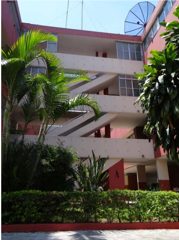
Figura 75 – CECAP Zezinho Magalhães Prado - Guarulhos/SP - Caixa de escada em único lance - 3ª Etapa (1972-1976) - Detalhe guarda-corpo
