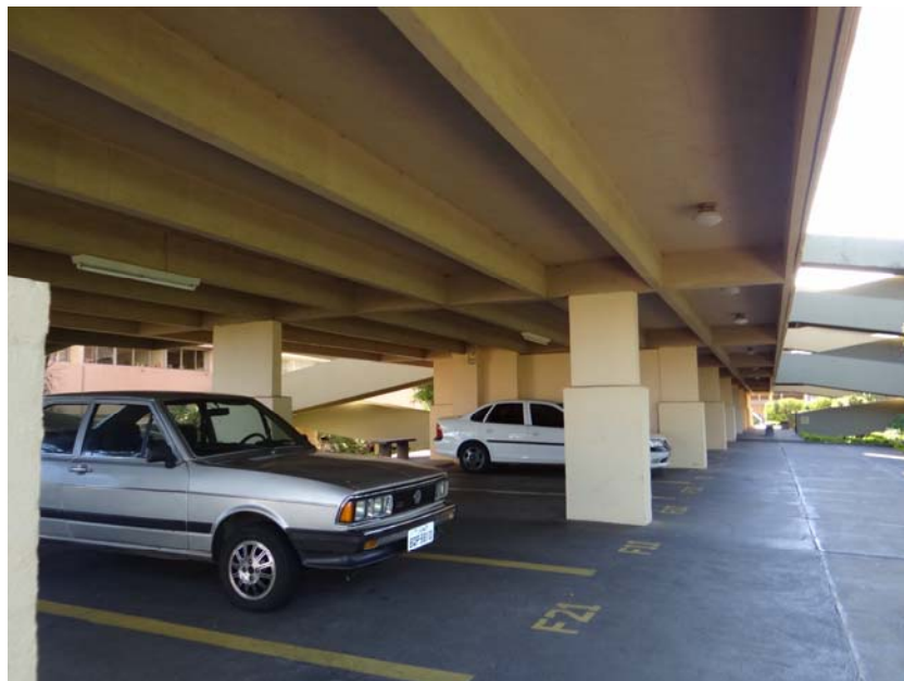
Figura 106 –CECAP Maria Izabel - Marília/SP - Vigas aparentes Pavimento Térreo
