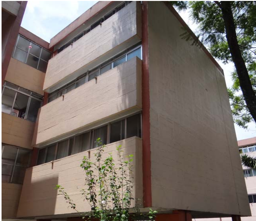
Figura 110 –CECAP Zezinho Magalhães Prado - Guarulhos/SP - Vedação Externa - 1ª Etapa (1968-1972)
