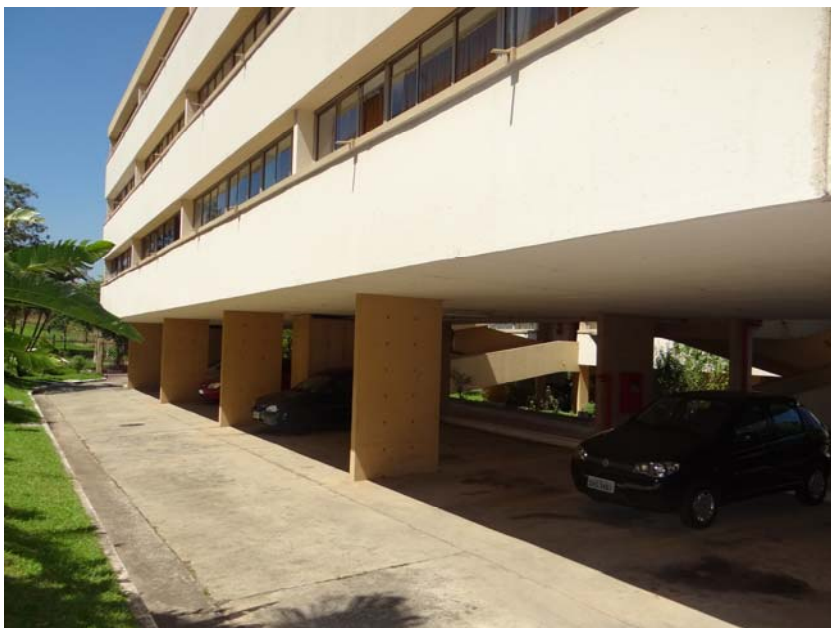
Figura 90 – CECAP Jundiaí/SP - Distribuição Pilares Pavimento Térreo
