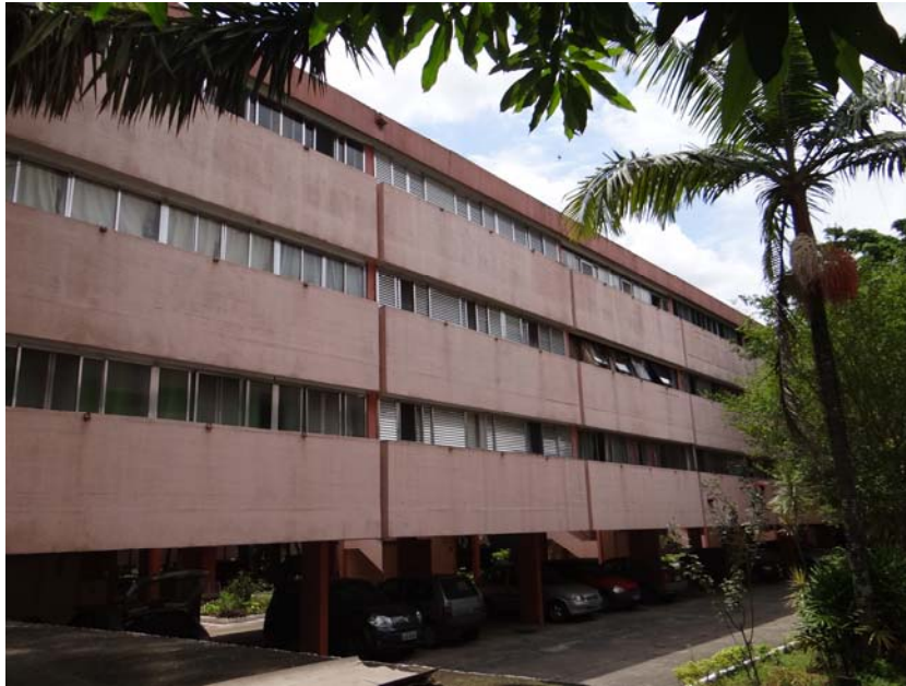
Figura 122 –CECAP Zezinho Magalhães Prado - Guarulhos/SP - Armários Segmentados no limite dos apartamentos - Vista Externa - 1ª Etapa (1968-1972)
