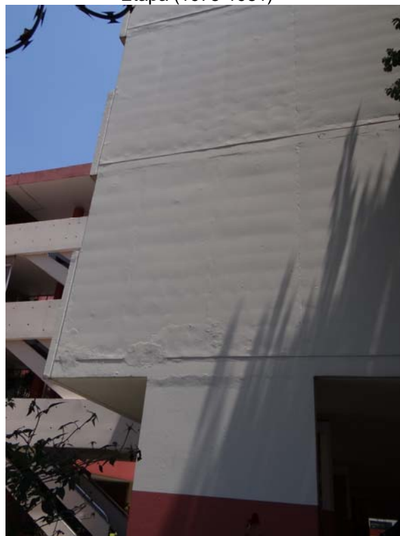
Figura 113 – CECAP Zezinho Magalhães Prado - Guarulhos/SP - Condomínio Bahia - Vedação Externa - 3ª Etapa (1978-1981)
