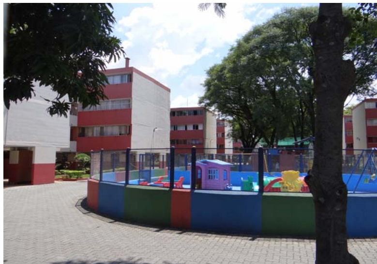
Figura 25 – CECAP Zezinho Magalhães Prado - Guarulhos/SP - Equipamentos de Lazer Condomínio Bahia
