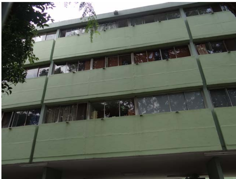
Figura 123 –CECAP Zezinho Magalhães Prado - Guarulhos/SP - Armários Segmentados no limite dos apartamentos - Vedação em painel de concreto - 2ª Etapa (1972-1976)
