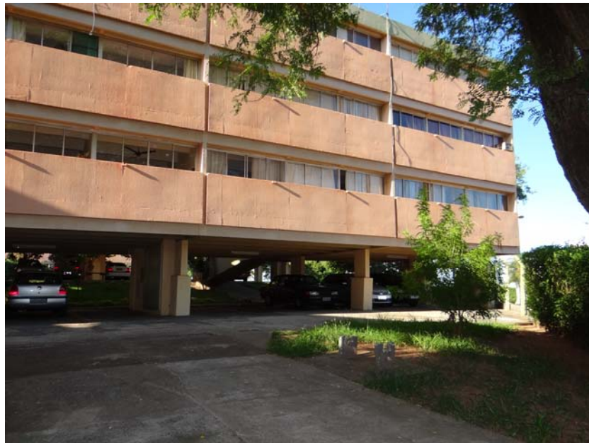
Figura 131 – CECAP Maria Izabel - Marília/SP - Armários Segmentados - Vedação em concreto
