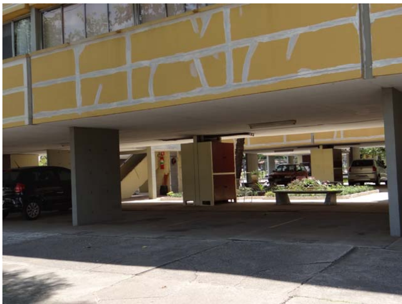
Figura 98 – CECAP Zezinho Magalhães Prado - Guarulhos/SP - Lajes Planas Pavimento Térreo - 2ª Etapa (1972-1976)
