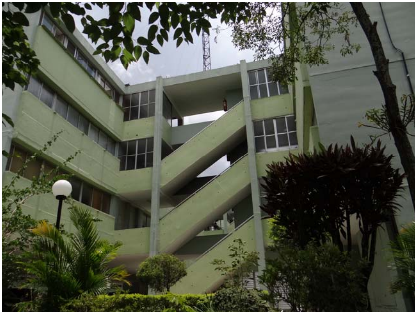
Figura 74 – CECAP Zezinho Magalhães Prado - Guarulhos/SP - Caixa de escada em único lance - 2ª Etapa (1972-1976)
