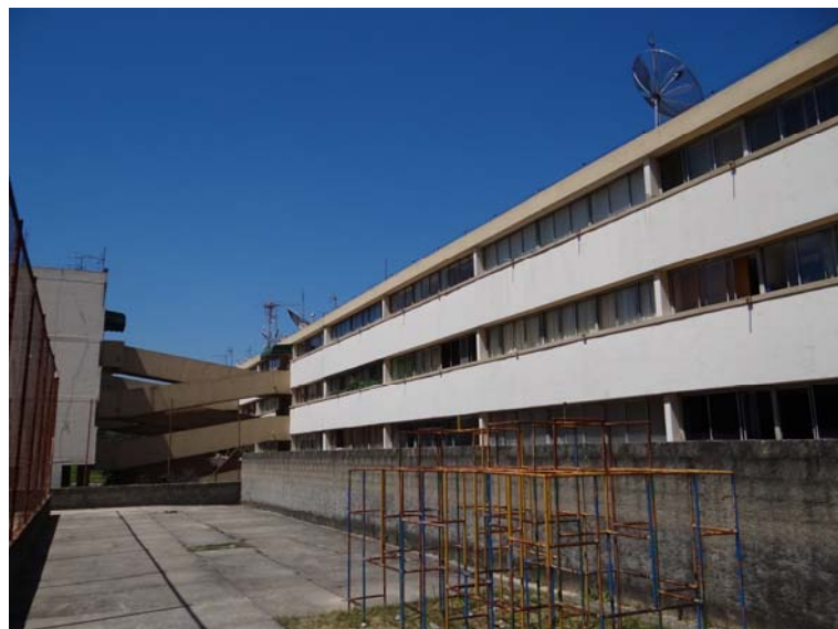
Figura 128 –CECAP Jundiaí/SP - Armários Contínuos - Vedação em concreto
