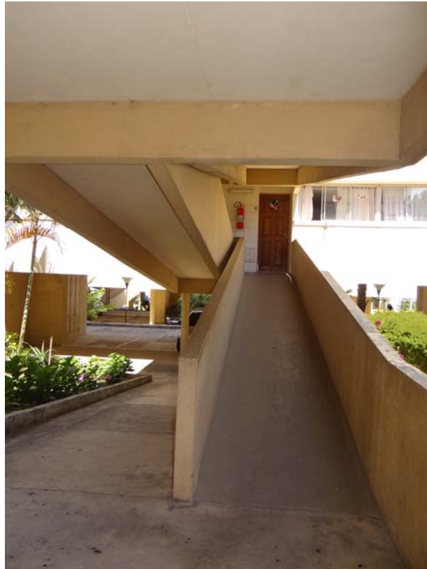
Figura 78 – CECAP Jundiaí/SP - Vista Rampa
