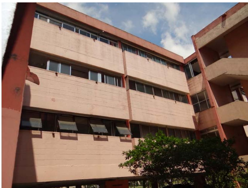
Figura 121 –CECAP Zezinho Magalhães Prado - Guarulhos/SP - Armários - Vedação Externa em blocos de concreto - 1ª Etapa (1968-1972)
