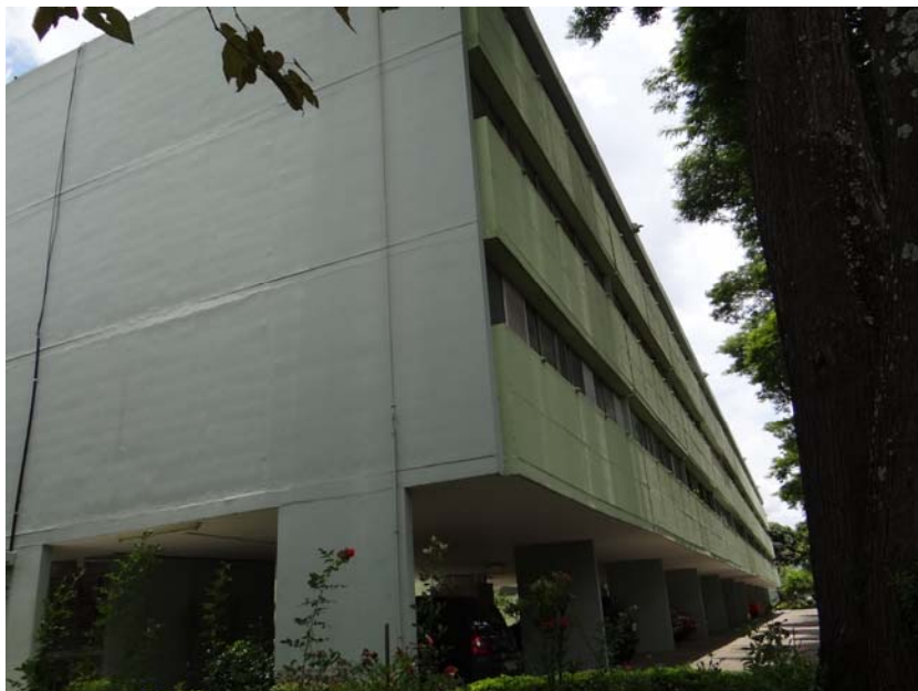
Figura 111 –CECAP Zezinho Magalhães Prado - Guarulhos/SP - Condomínio Minas Gerais - Vedação Externa - 2ª Etapa (1972-1976)
