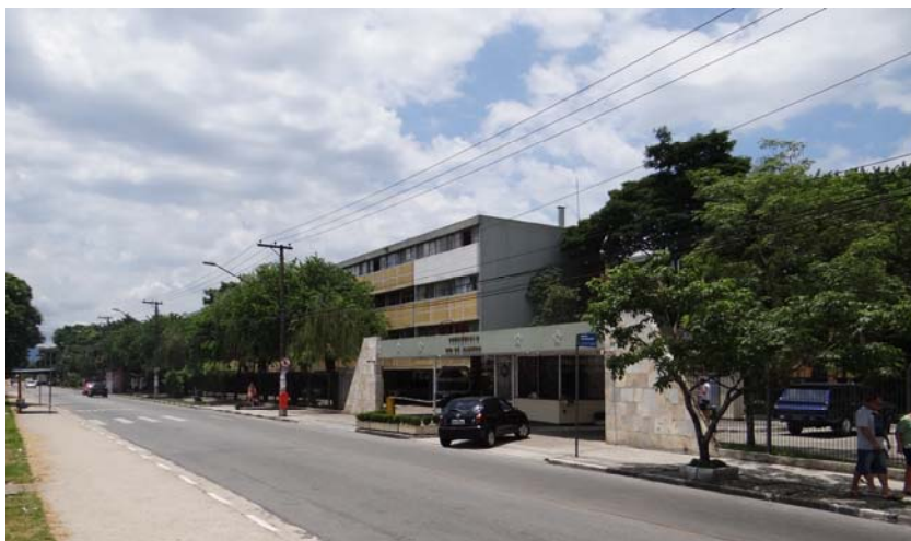
Figura 27 – CECAP Zezinho Magalhães Prado - Guarulhos/SP - Portaria Condomínio Rio de Janeiro
