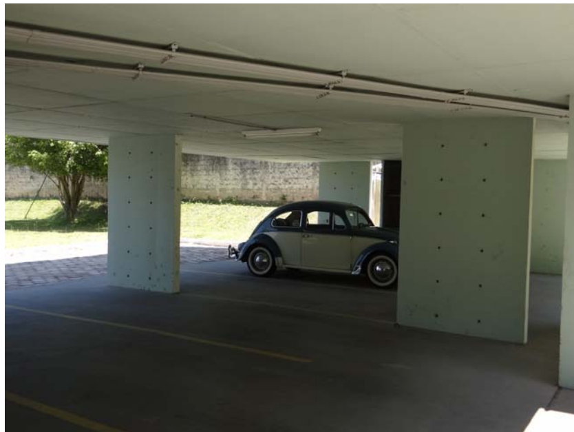
Figura 101 –CECAP Jundiaí/SP - Lajes Planas Pavimento Térreo
