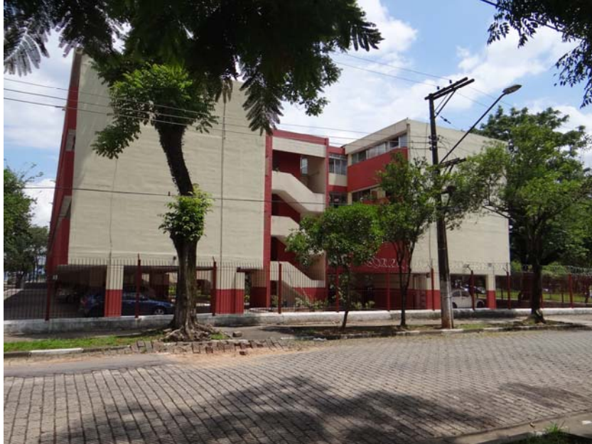
Figura 135 –CECAP Zezinho Magalhães Prado - Guarulhos/SP - Locação Blocos
