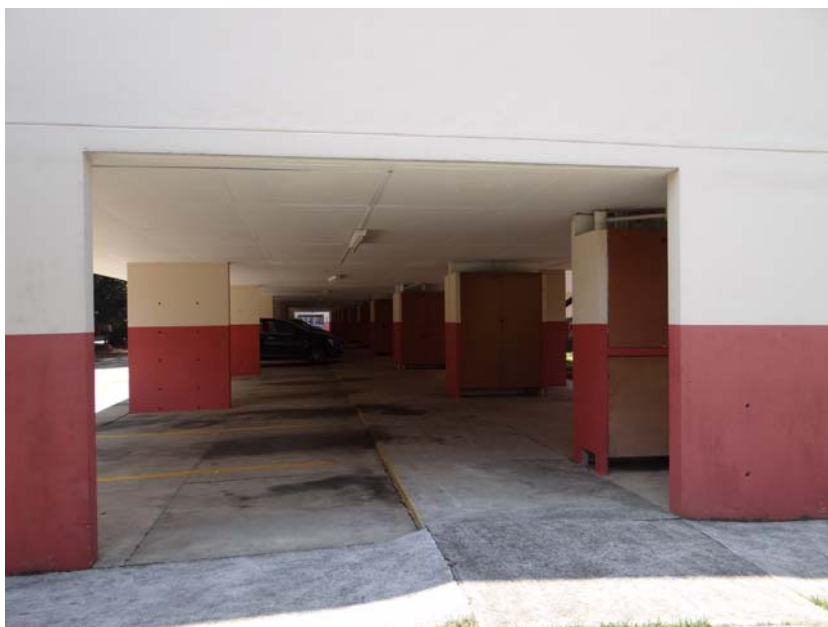
Figura 99 – CECAP Zezinho Magalhães Prado - Guarulhos/SP - Lajes Planas Pavimento Térreo - 3ª Etapa (1978-1981)
