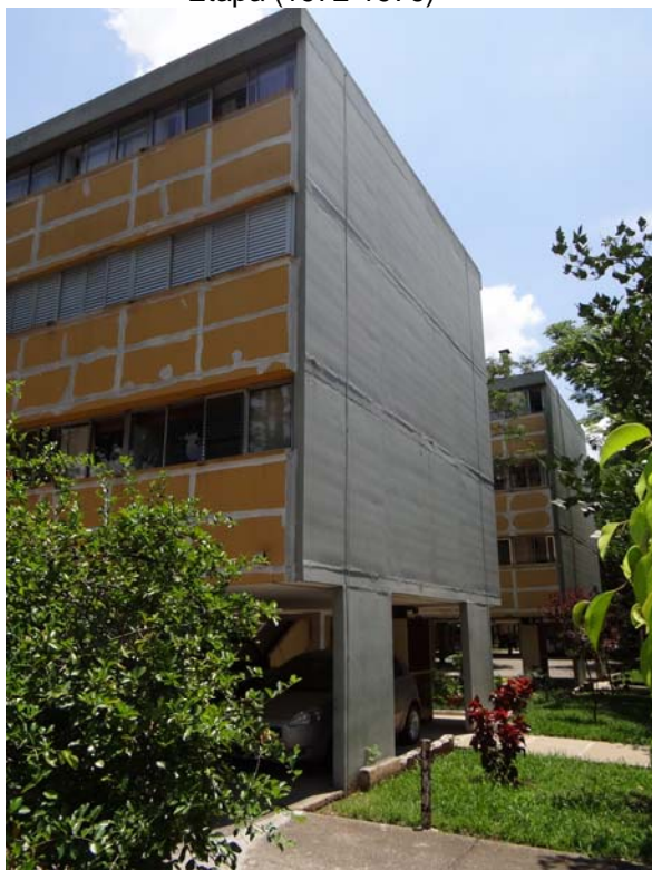
Figura 112 – CECAP Zezinho Magalhães Prado - Guarulhos/SP - Condomínio Rio de Janeiro - Vedação Externa - 2ª Etapa (1972-1976)
