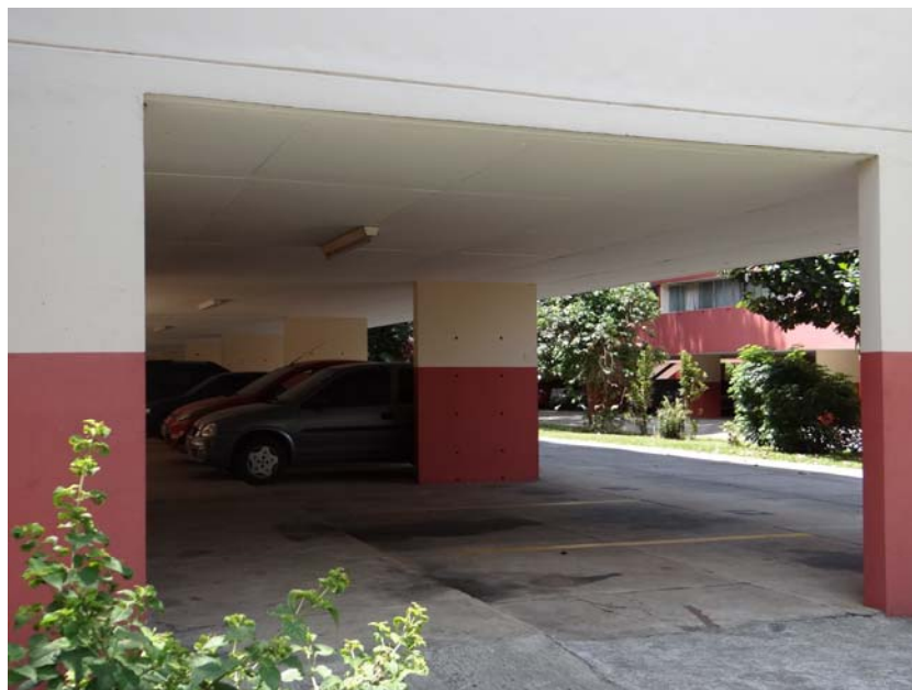
Figura 86 – CECAP Zezinho Magalhães Prado - Guarulhos/SP - Pilares Pavimento Térreo - 3ª Etapa (1978-1981)
