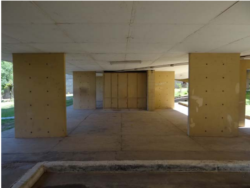
Figura 89 – CECAP Jundiaí/SP - Pilares Pavimento Térreo
