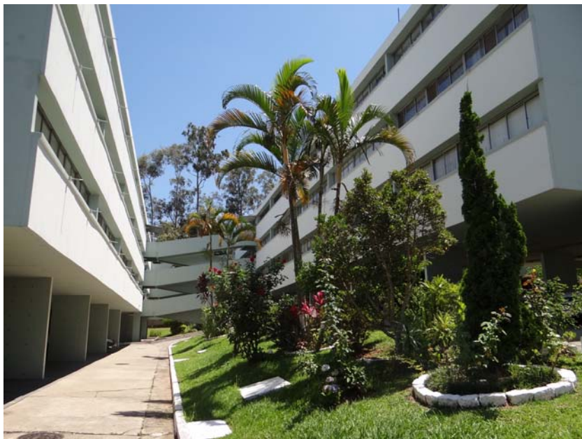
Figura 138 –CECAP Jundiaí/SP - Diferença de nível entre edifícios
