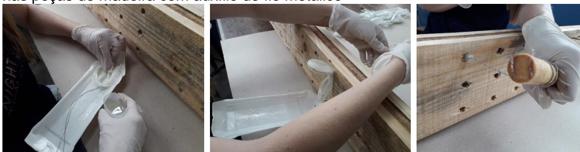
Figura 64 - Fibra sendo impregnada com resina e fibra impregnada sendo passada nas peças de madeira com auxílio de fio metálico
