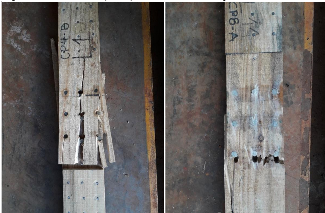
Figura 76 - Modo de ruptura por cisalhamento longitudinal e transversal
