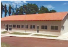
Biblioteca construída por iniciativa da comunidade tem poucos frequentadores
