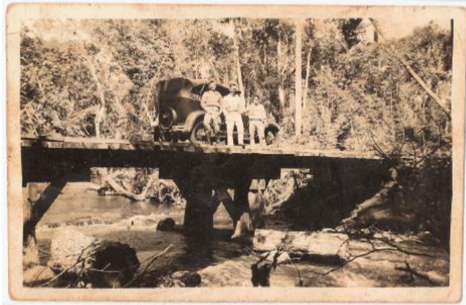
Figura 13 – Ponte sobre o Rio Pirapó
