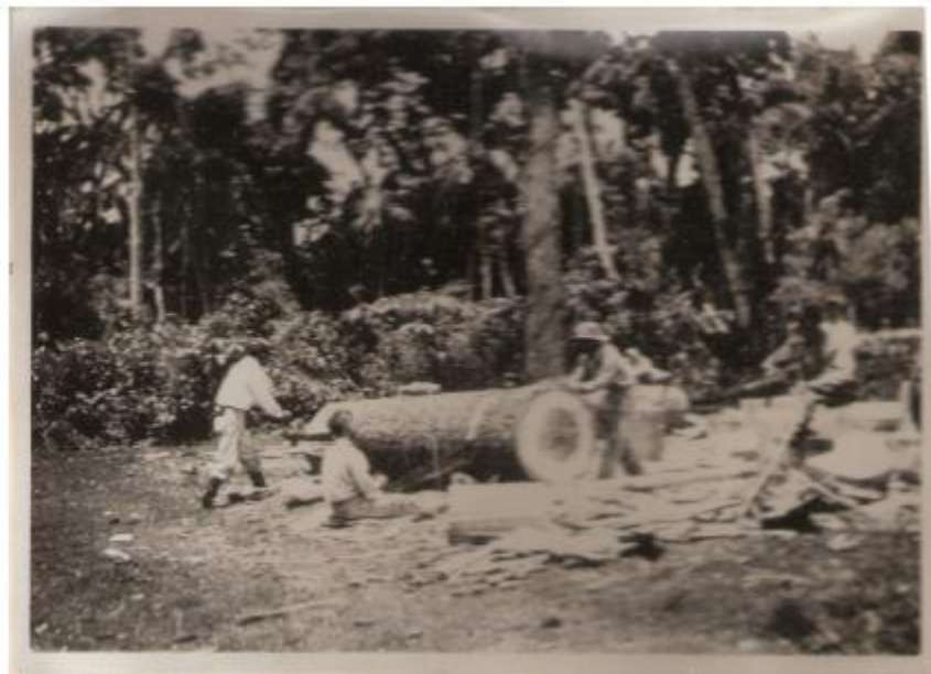
Figura 8 – Serragem de grande tora com serra manual
