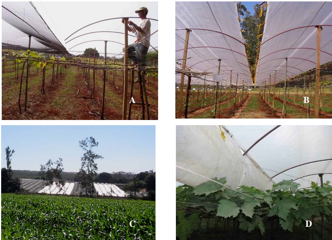
Figura 3.2 – A: Instalação da cobertura plástica; B: Cobertura recém-instalada; C: Vista do experimento sob sombrite e cobertura plástica; D: Calha plástica para evitar respingos de água da chuva sobre as videiras.
