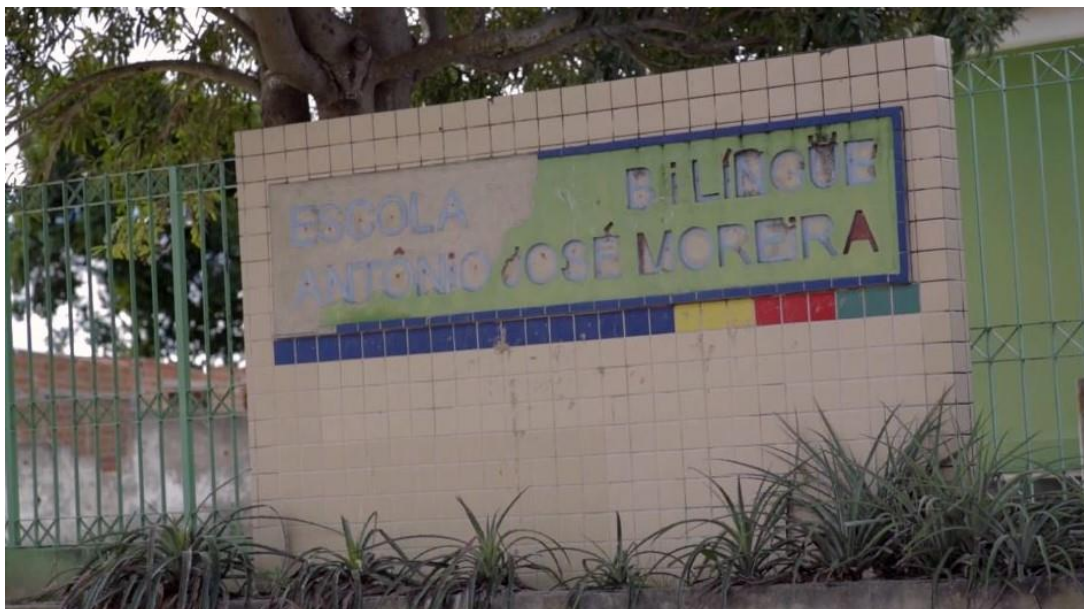
Figura 43 - Fachada da Escola Bilíngue Antônio José Moreira
