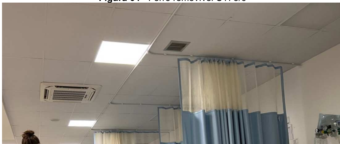
Figura 64 - Forro removível UTI 5/6
