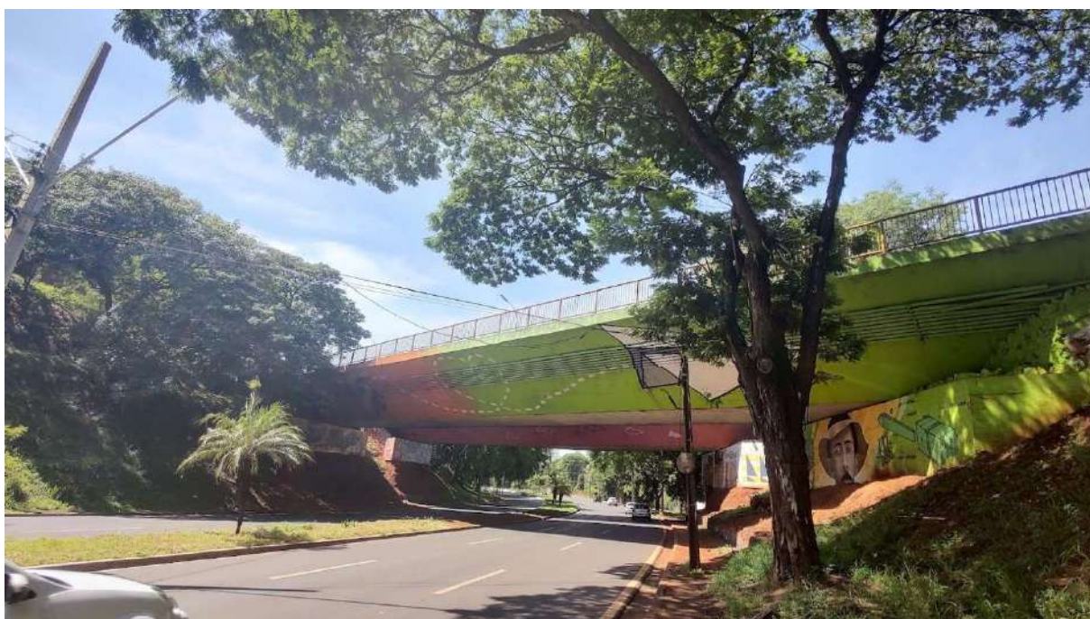
Figura 30 – Viaduto sob a Av. Santos Dumont
