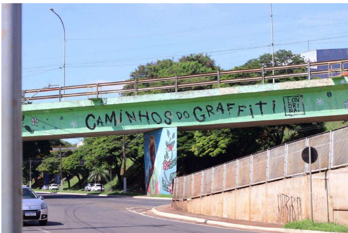
Figura 7 – Viaduto sob a Av. Martiniano do Valle Filho
