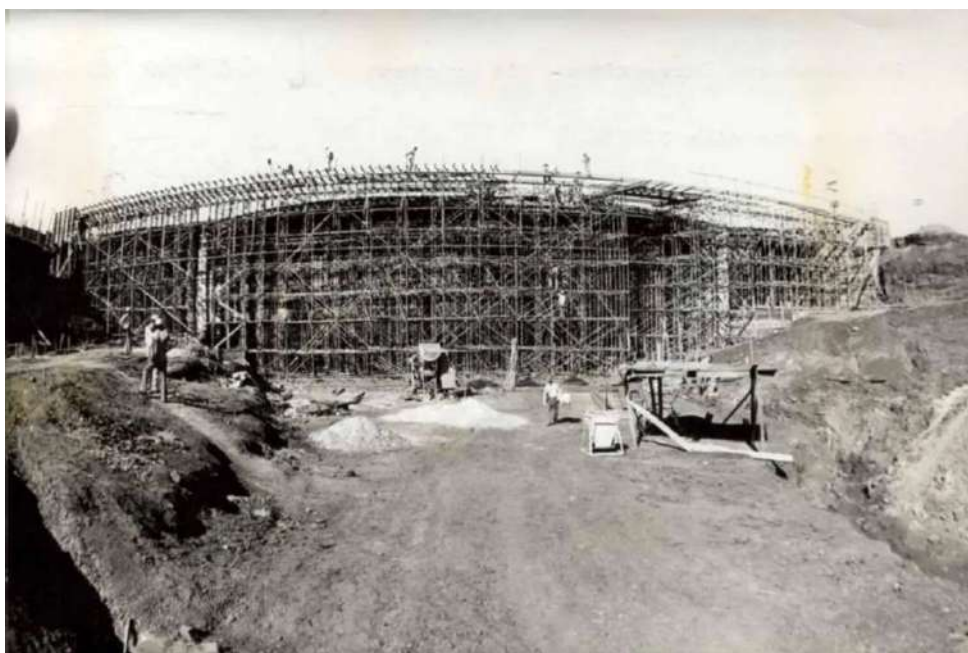
Figura 3 – Construção do viaduto da Avenida Juscelino Kubitschek
