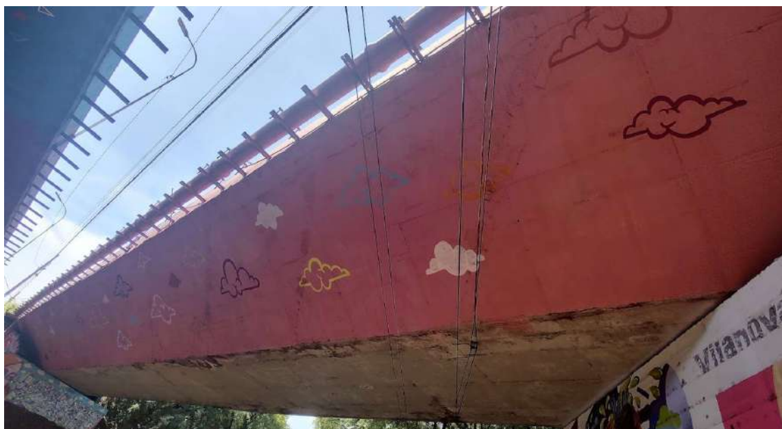
Figura 39 – Face do segundo viaduto sob a Av. Santos Dumont
