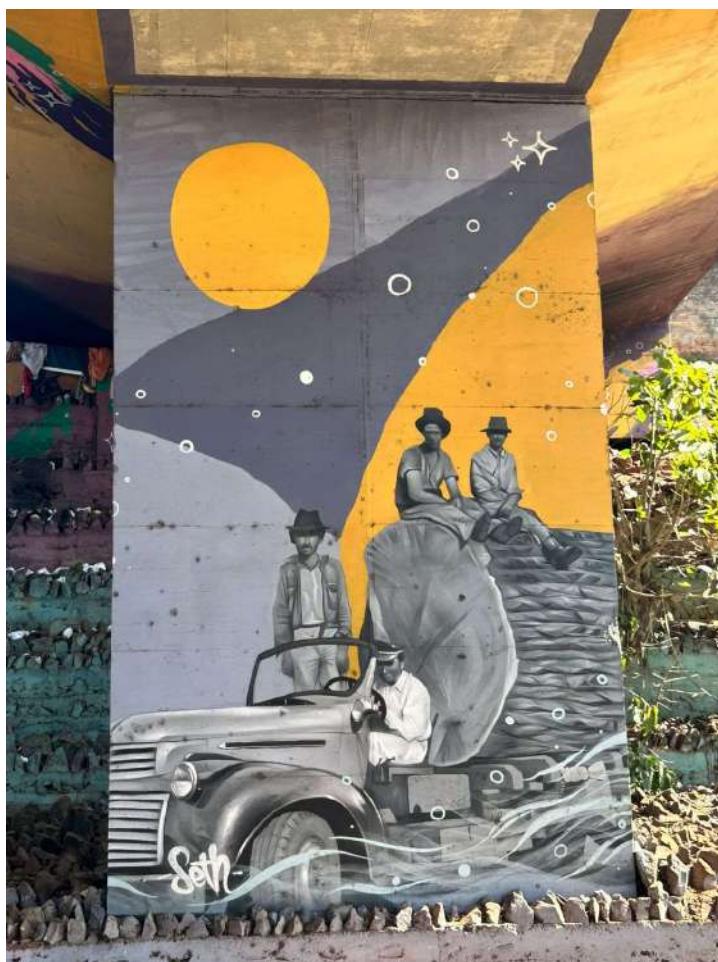
Figura 20 – Mesoestrutura do Viaduto sob a Av. Celso Garcia Cid
