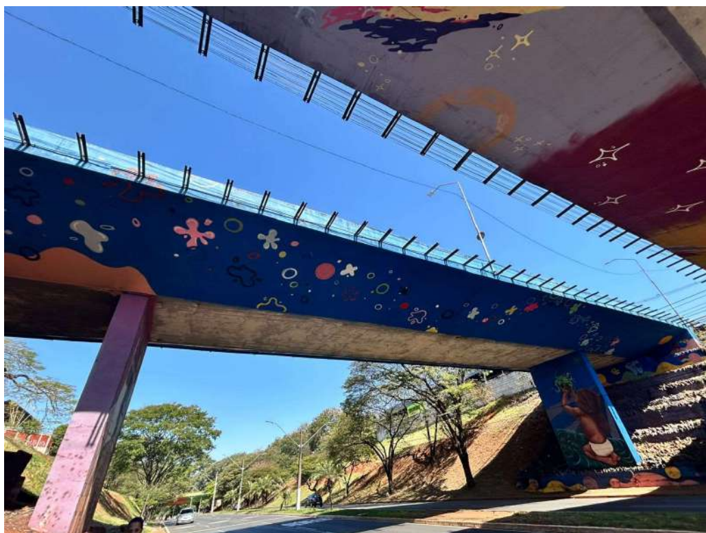
Figura 23 – Segundo viaduto sob a Av. Celso Garcia Cid
