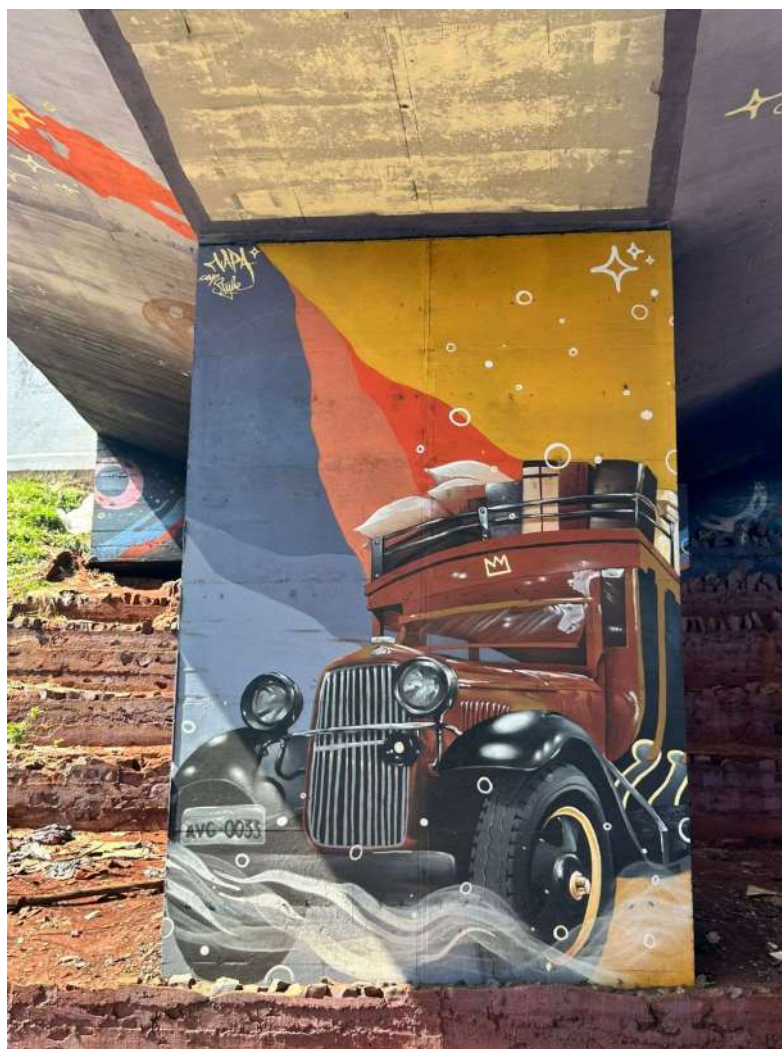
Figura 21 – Outra mesoestrutura do Viaduto sob a Av. Celso Garcia Cid
