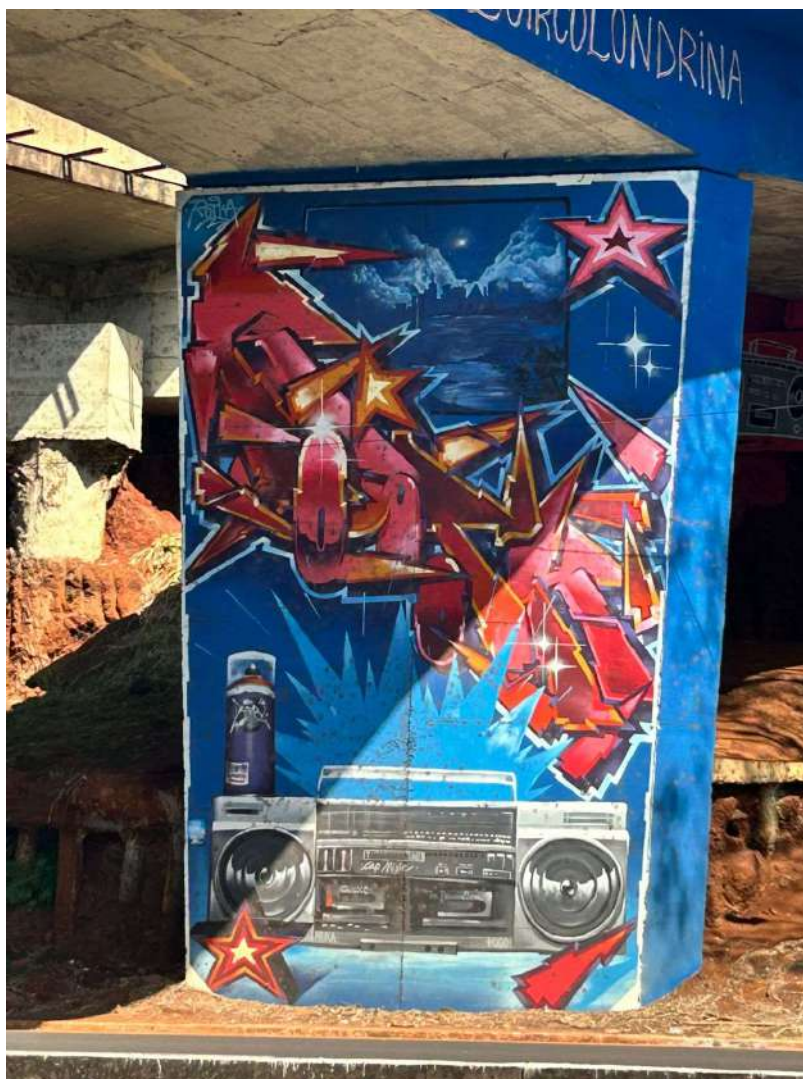
Figura 54 – Pilastra direita do Viaduto sob a Av. Juscelino Kubitschek
