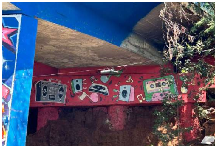
Figura 55 – Mesoestrutura direita do Viaduto sob a Av. Juscelino Kubitschek
