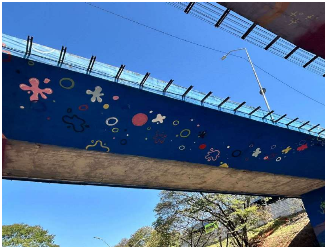
Figura 24 – Destaque dado a face do segundo viaduto sob a Av. Celso Garcia Cid
