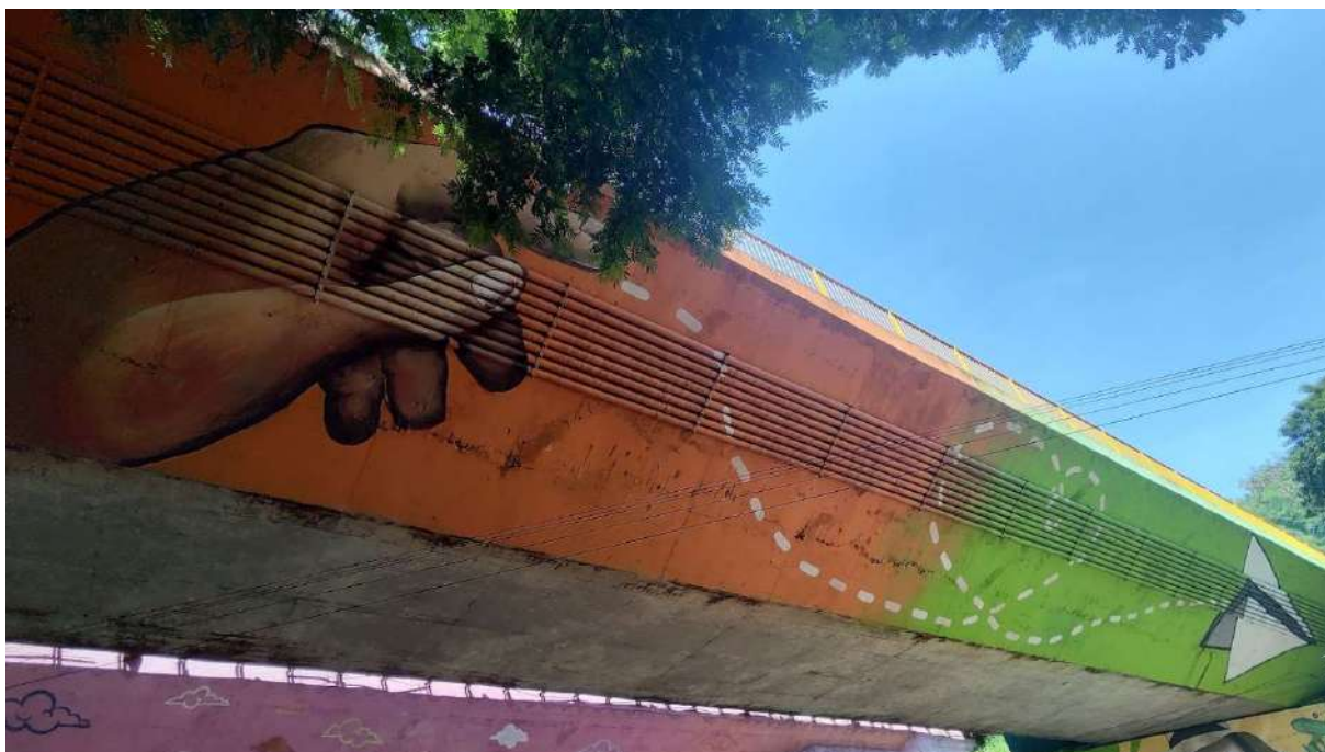
Figura 31 – Face do viaduto sob a Av. Santos Dumont
