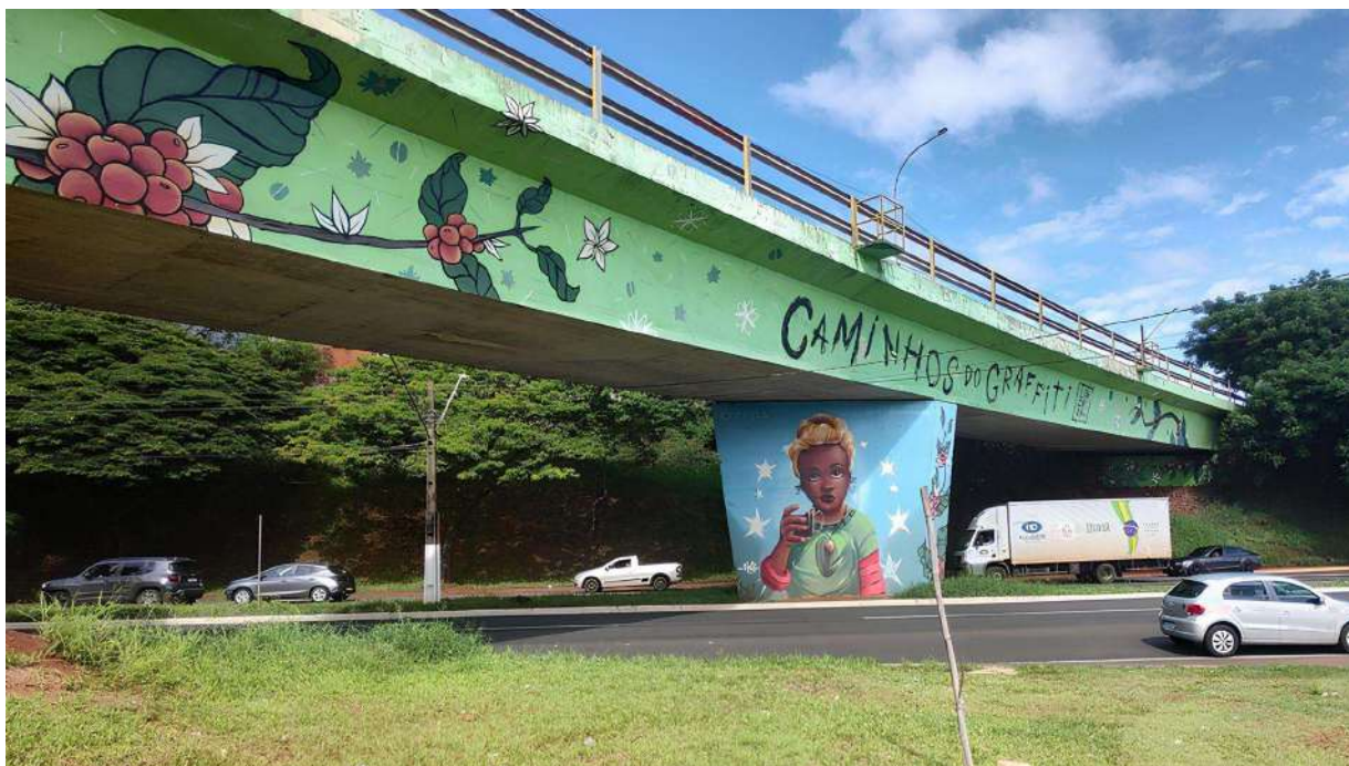
Figura 6 – Viaduto sob a Av.Martiniano do Valle Filho
