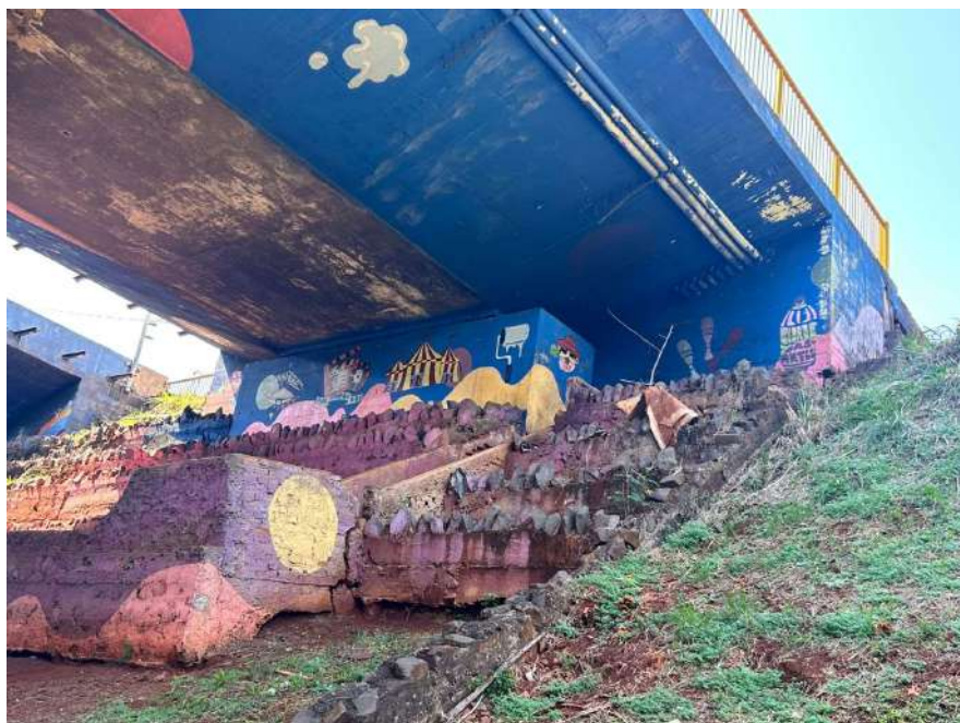
Figura 28 – Intervenções encontradas atrás da coluna a esquerda
