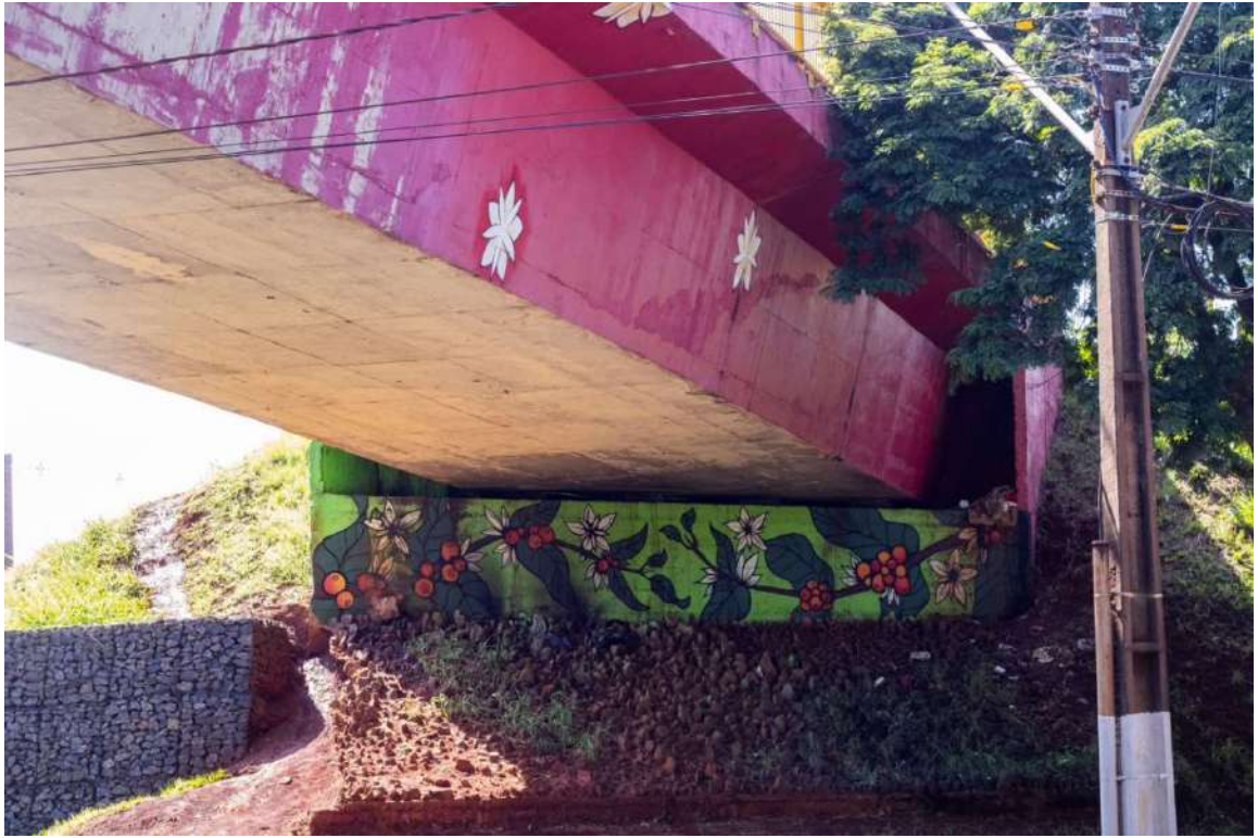
Figura 11 – Lateral do Viaduto sob a Av. Martiniano do Valle Filho
