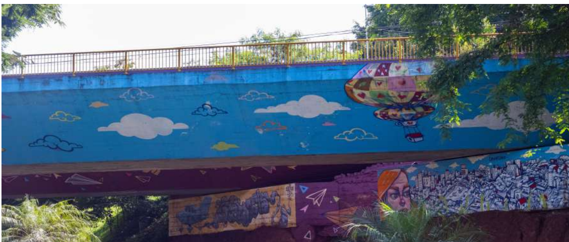
Figura 50 – Detalhe presente na outra face do segundo viaduto sob a Av. Santos Dumont
