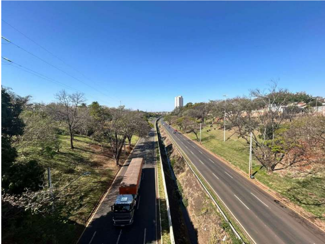
Figura 4 – Vista da Avenida Dez de Dezembro acima do viaduto da Avenida Juscelino Kubitschek
