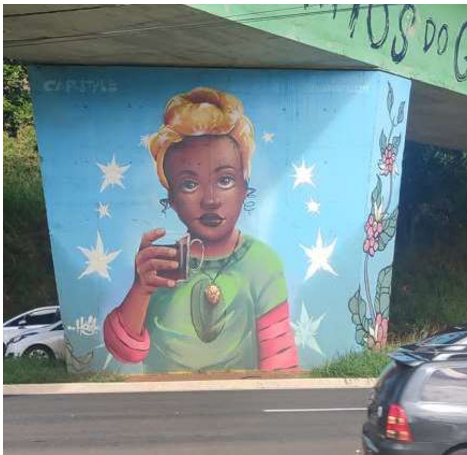
Figura 12 – Mesoestrutura do Viaduto sob a Av. Martiniano do Valle Filho
