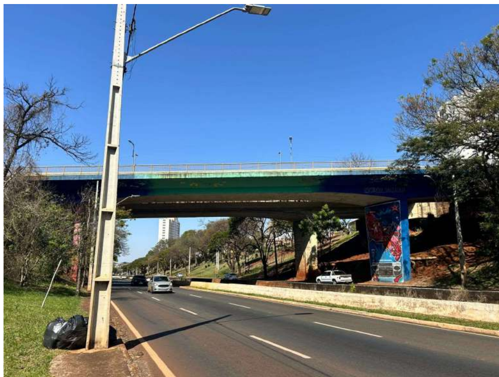
Figura 52 – Viaduto sob a Av. Juscelino Kubitschek
