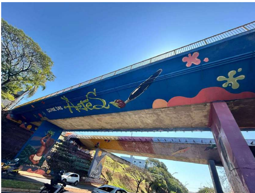
Figura 29 – Outro lado do Viaduto sob a Av. Celso Garcia Cid
