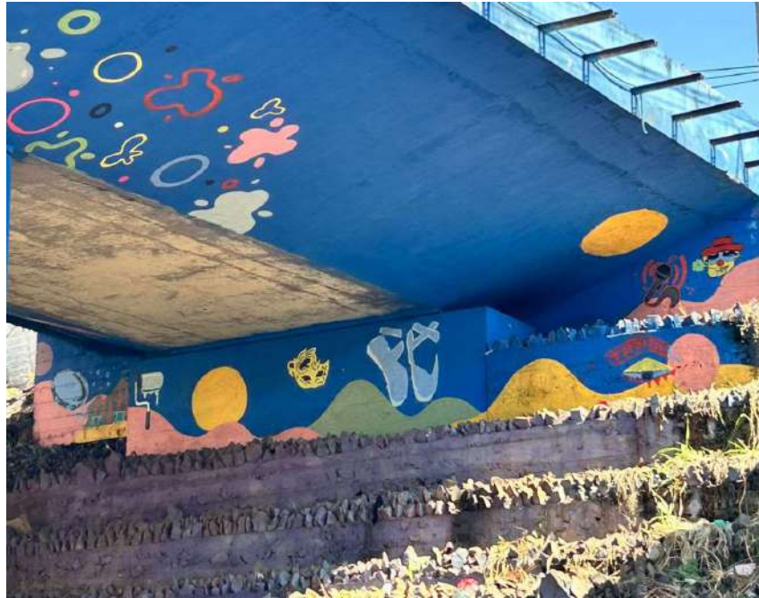
Figura 27 – Intervenções encontradas atrás da coluna a direita
