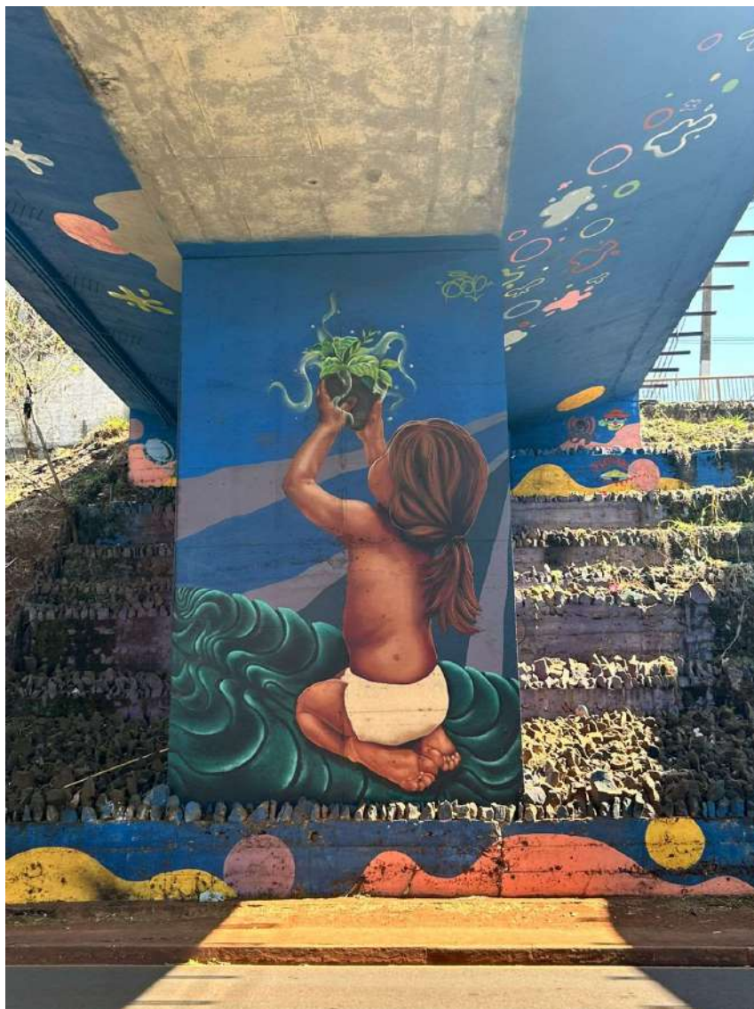
Figura 25 – Mesoestrutura do segundo Viaduto sob a Av. Celso Garcia Cid
