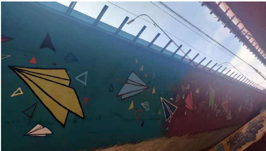
Figura 38 – Outra face do viaduto sob a Av. Santos Dumont, com detalhes.
