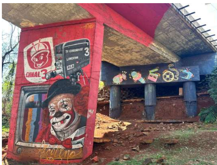
Figura 57 – Mesoestrutura direita do Viaduto sob a Av. Juscelino Kubitschek
