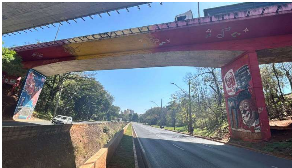
Figura 58 – Face dianteira do Viaduto sob a Av. Juscelino Kubitschek
