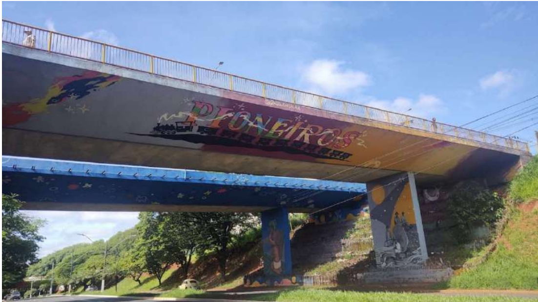
Figura 17 – Viaduto sob a Av. Celso Garcia Cid
