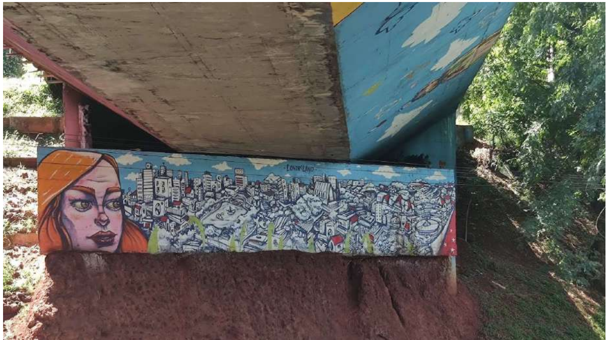
Figura 44 – Mesoestrutura esquerda do segundo viaduto sob a Av. Santos Dumont
