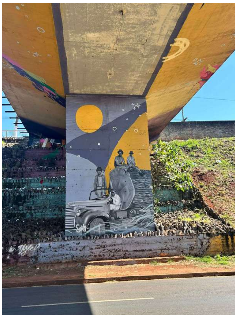
Figura 19 – Mesoestrutura do Viaduto sob a Av. Celso Garcia Cid
