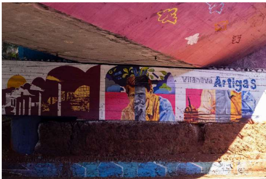
Figura 41 – Coluna direita do segundo viaduto sob a Av. Santos Dumont
