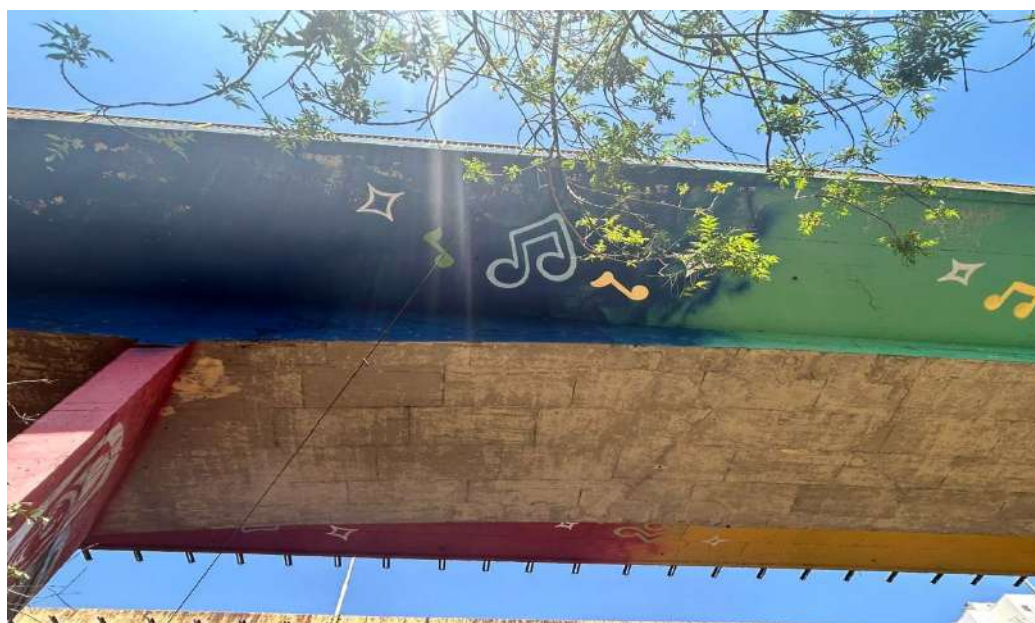
Figura 53 – Viaduto sob a Av. Juscelino Kubitschek
