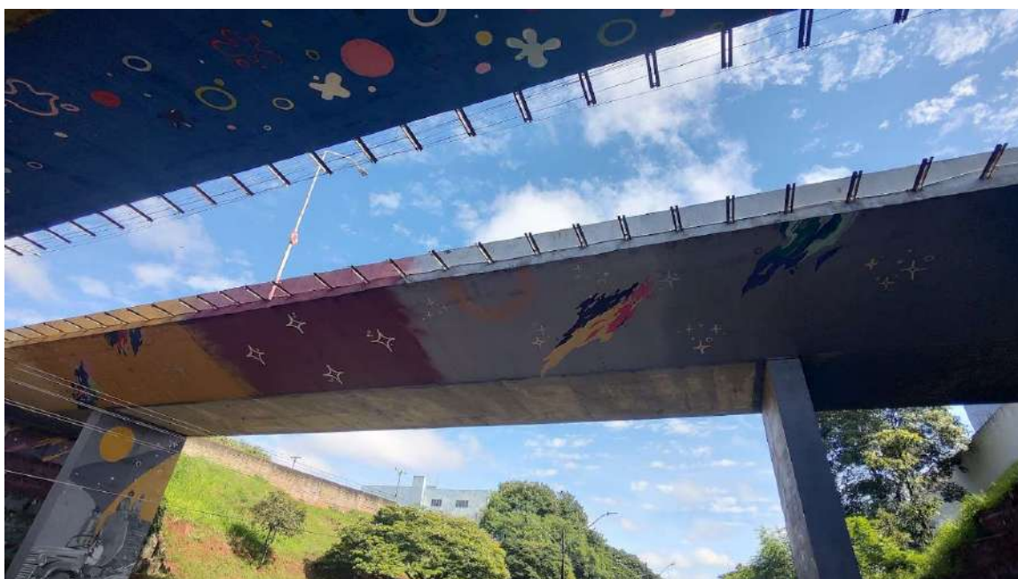
Figura 22 – Outro face como “transição” do viaduto sob a Av. Celso Garcia Cid
