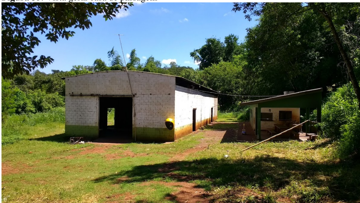
Figura 35. Vista geral casa de passagem
