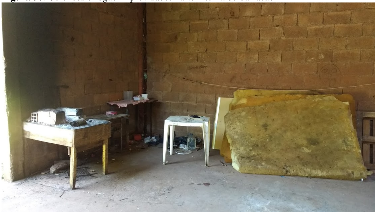
Figura 36. Colchões e fogão improvisado. Parte interna do barracão
