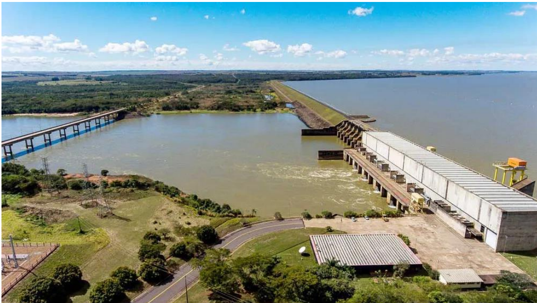
Figura 1 - Usina Hidrelétrica Rosana - CTG Brasil
