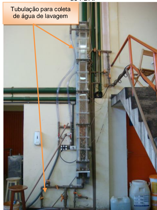
Figura 25 – Tubulações para coleta de água de lavagem ligadas ao reservatório de resíduos da instalação piloto de FDAP
