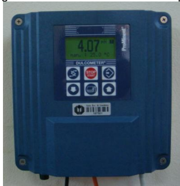
Figura 17 – Foto do controlador de pH
