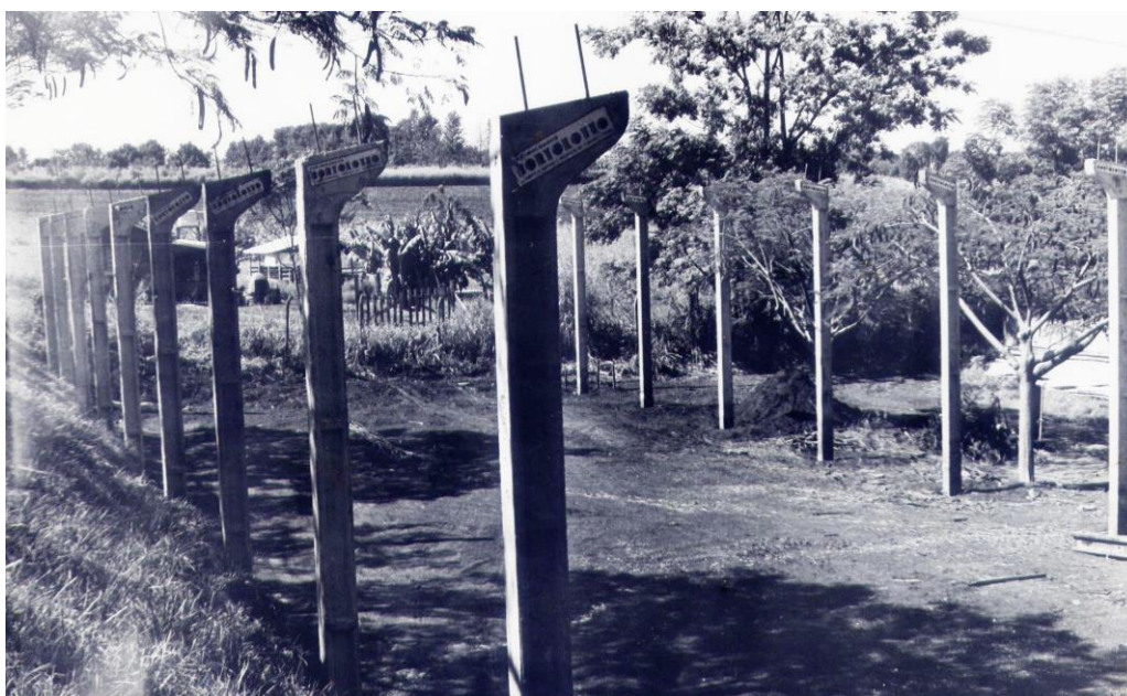
Foto 4 - Construção do prédio sede com estrutura pré-moldado
