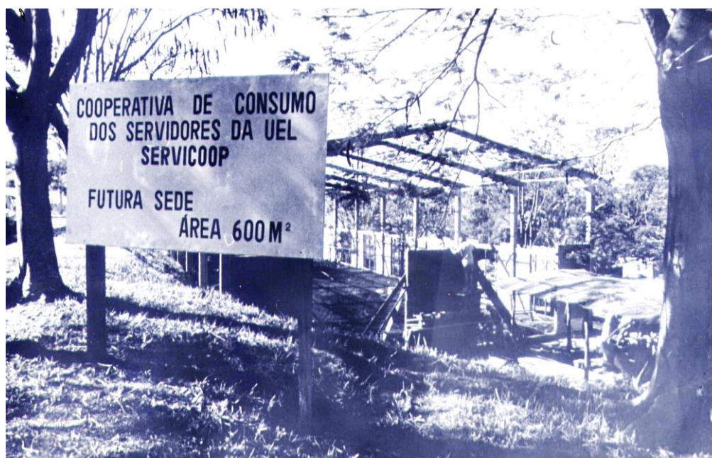
Foto 3 - Início da construção do prédio sede da cooperativa
