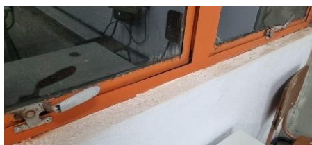
Figura 24 – Vão presente nas esquadrias máximo-ar
