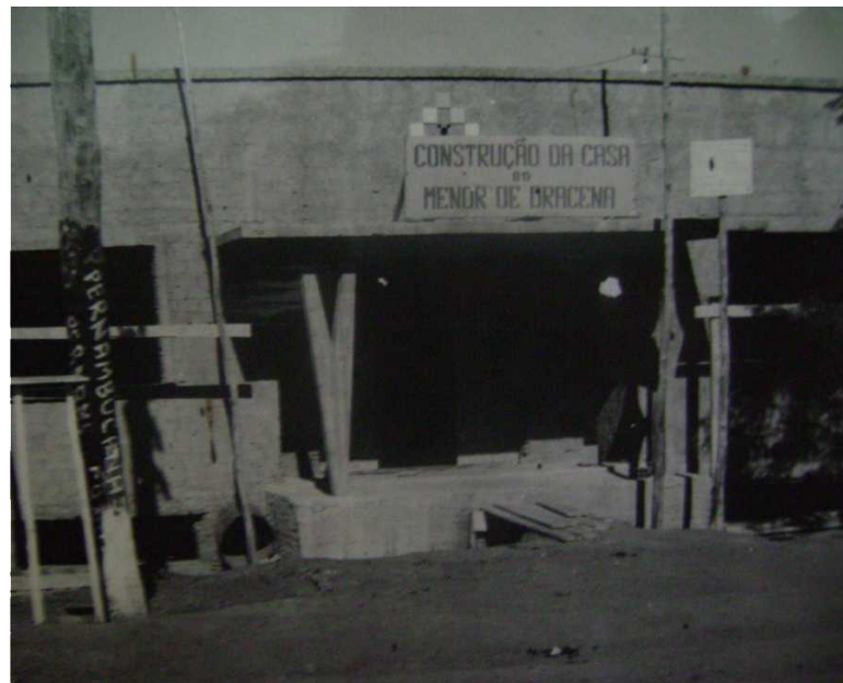
Figura 6 - Construção da Casa do Menor Fonte: Casa do Menor de Dracena.
