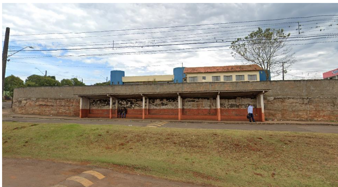
Figura 14 – Atual terminal de Tamarana
