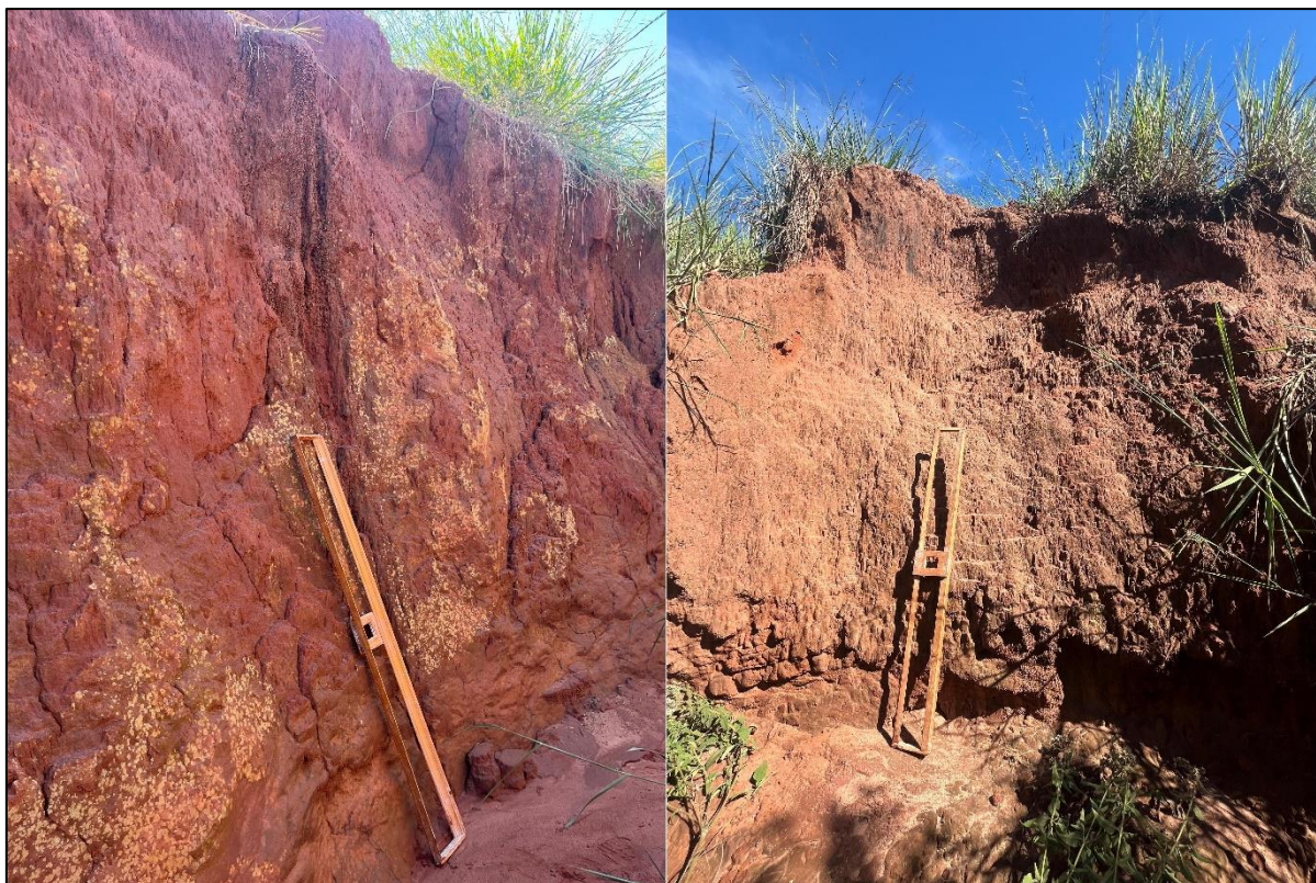
Figura 43 – Profundidade e alargamento da calha da voçoroca em média vertente.
