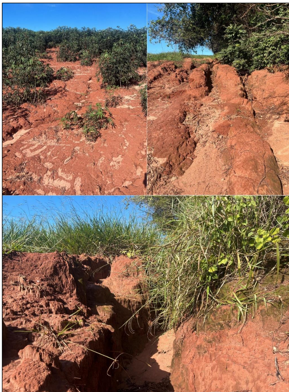
Figura 45 – Sulcos e processos de ravinamento em áreas adjacentes da voçoroca.
