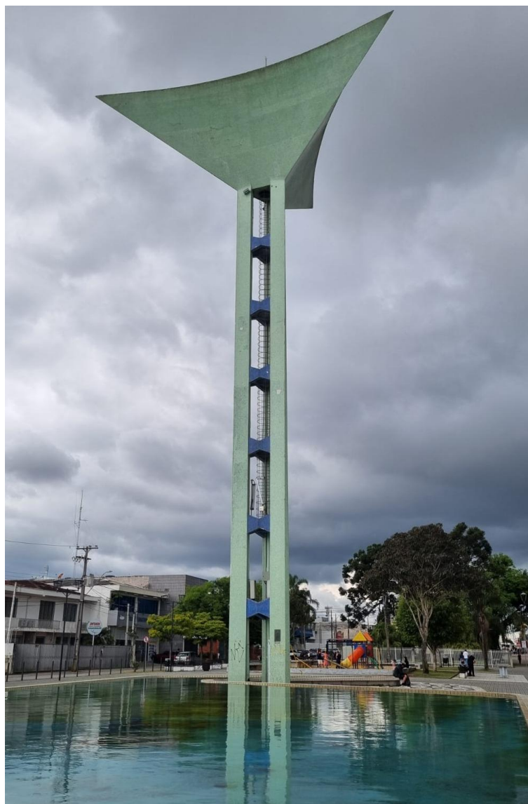
Figura 65 - Torre d'água de São José dos Pinhais
