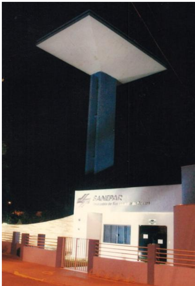
Figura 34 - Torre d'água de Rolândia
