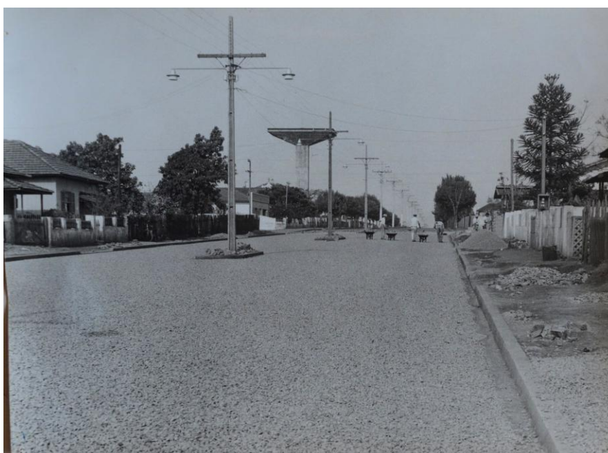
Figura 31 - Torre d'água de Rolândia
