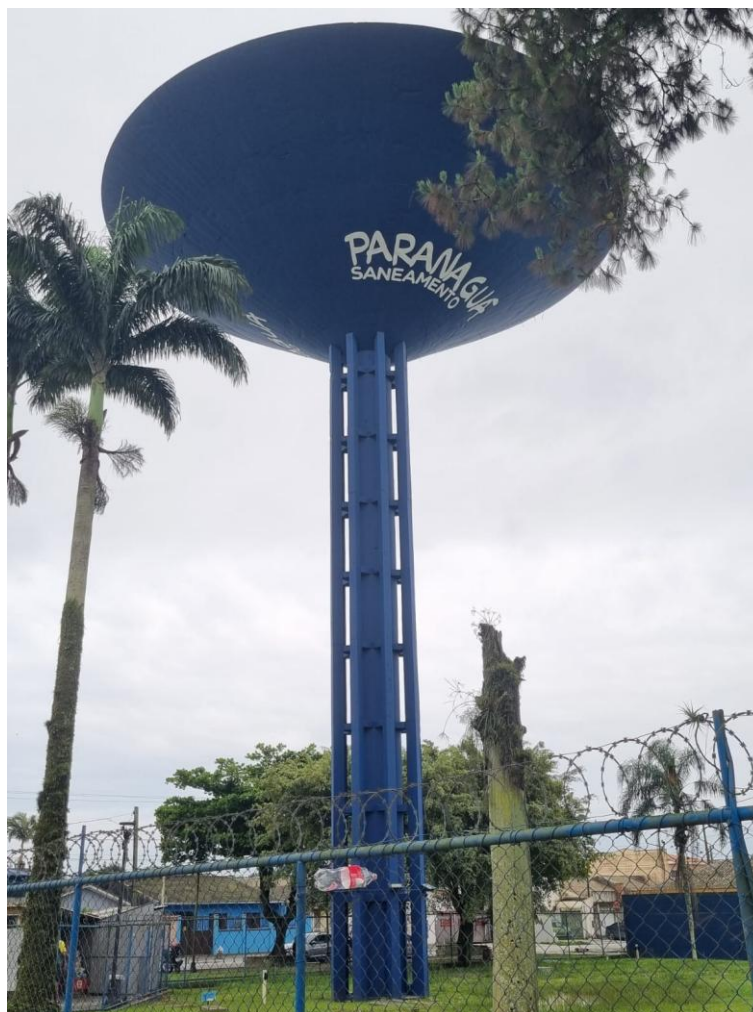
Figura 98 - Torre d'água de Paranaguá
