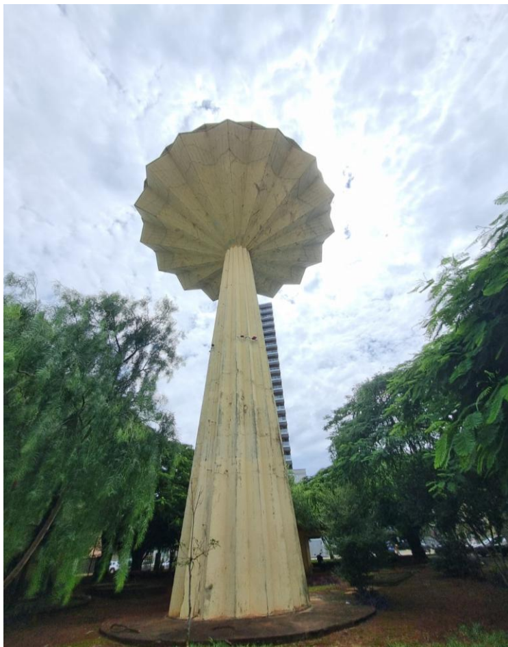
Figura 47 - Torre d'água de Arapongas
