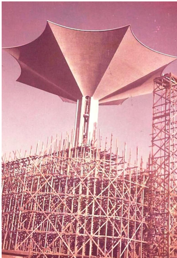
Figura 60 - Obra da Torre d'água de Maringá
