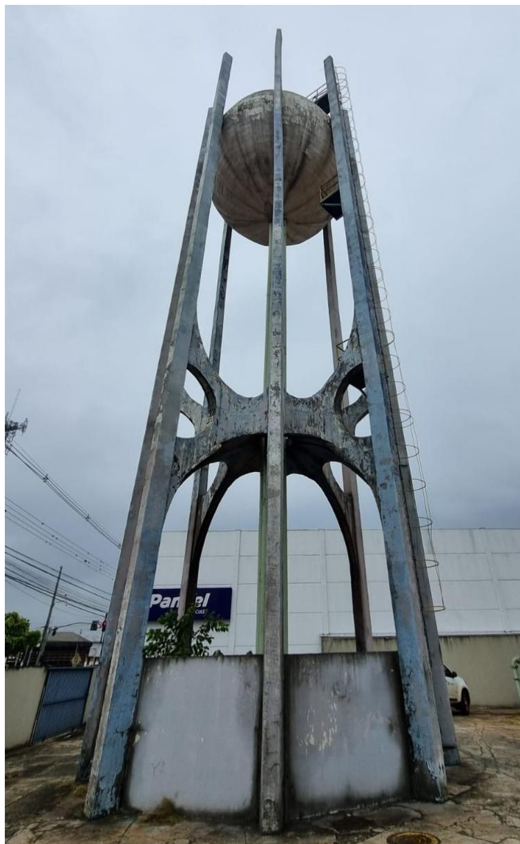
Figura 87 - Torre d'água de Cambé
