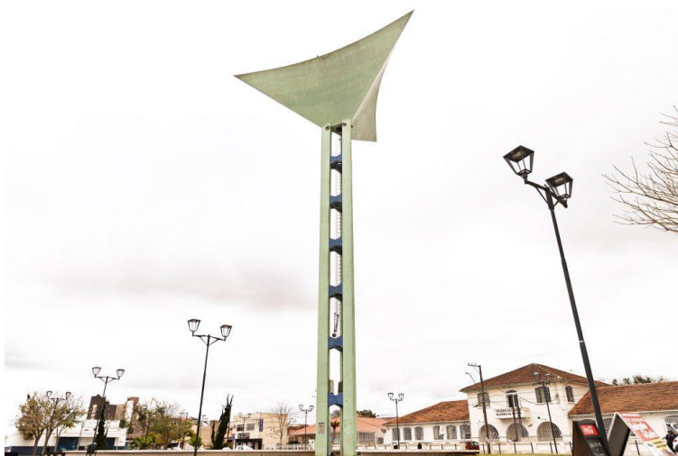
Figura 69 - Torre d'água de São José dos Pinhais
