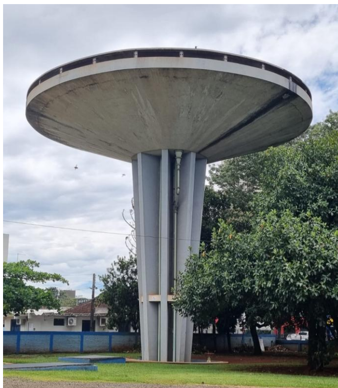
Figura 99 – Torre d'água de Mandaguari
