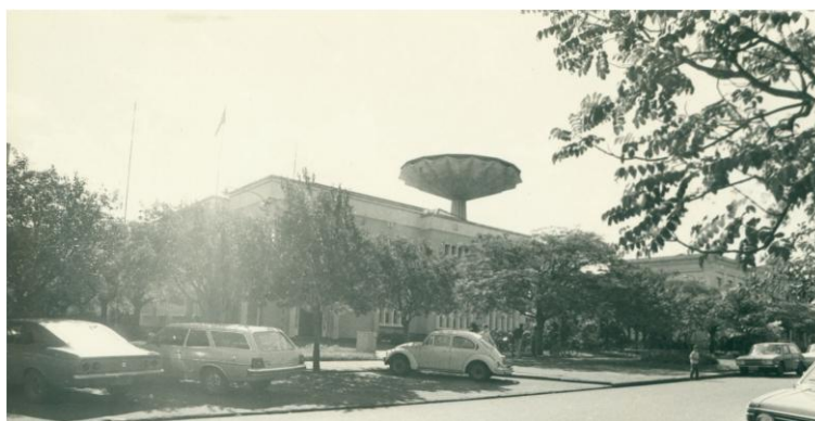
Figura 50 - Torre d'água de Arapongas
