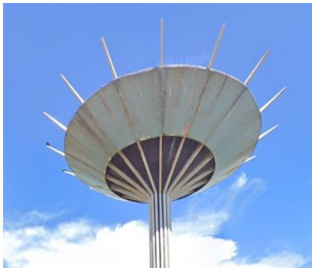
Figura 84- Torre d'água de Paranavaí Jardim São Jorge possivelmente com chapa metálica
