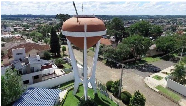
Figura 75 - Torre d'água de São Mateus do Sul
