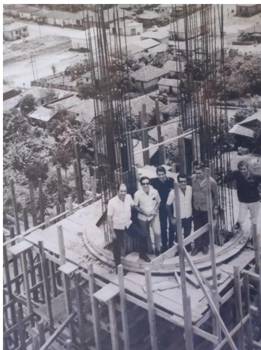
Figura 91 - Obra da torre d'água de Andirá
