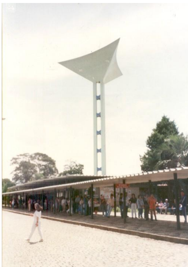
Figura 67 - Torre d'água de São José dos Pinhais
