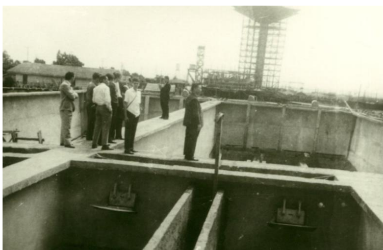
Figura 64 - Obra da Torre d'água de Maringá
