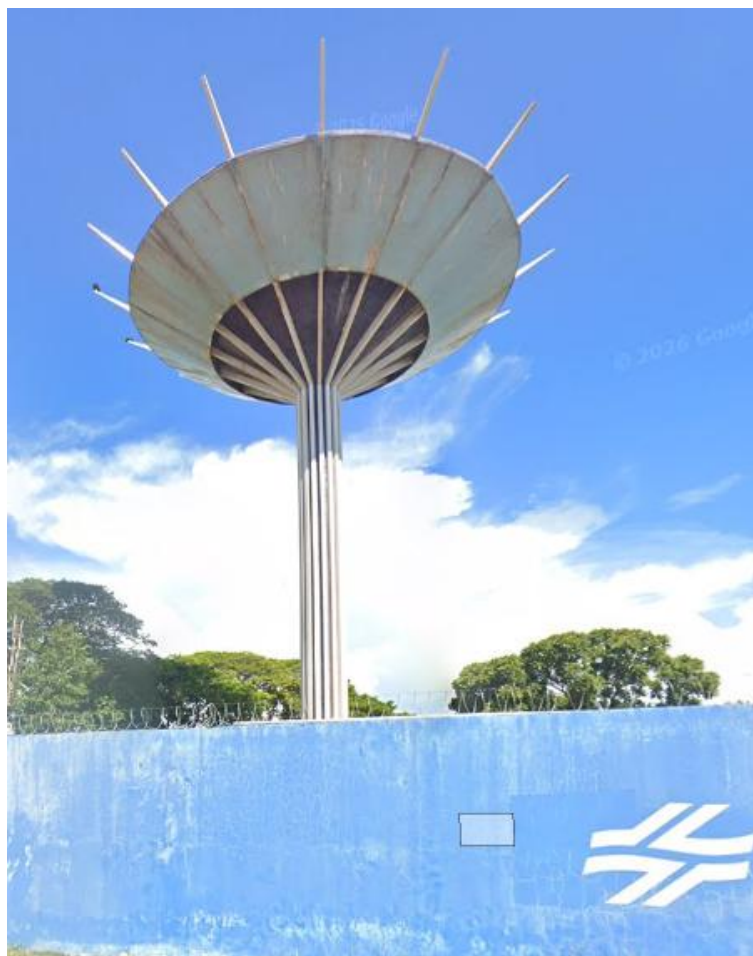
Figura 82 - Torre d'água de Paranaíba Jardim São Jorge
