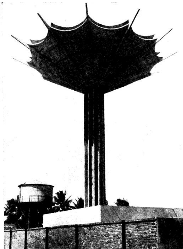
Figura 79 - Torre d'água de João Pessoa
