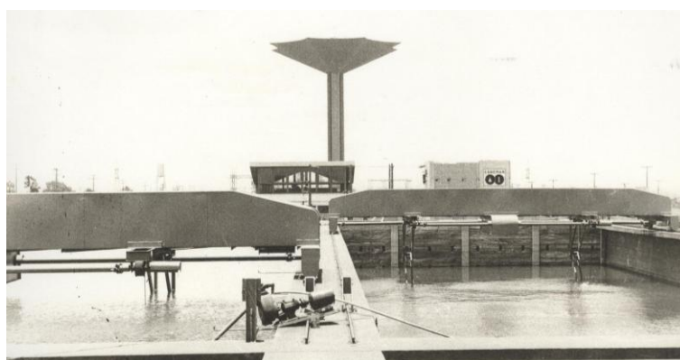
Figura 54 - Estação de tratamento de água de Maringá
