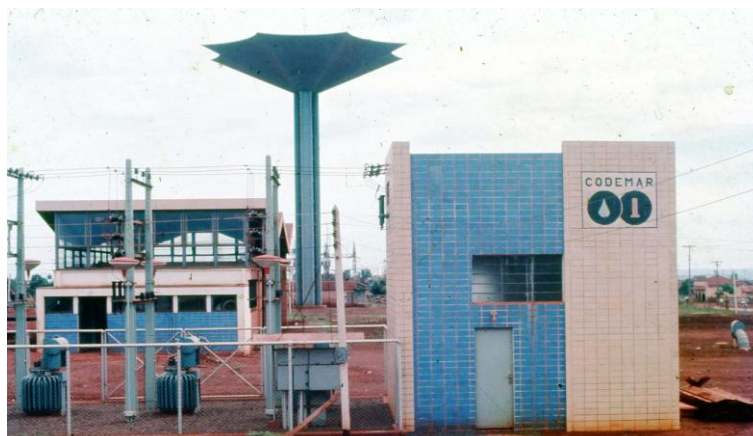
Figura 56 - Estação de tratamento de água de Maringá
