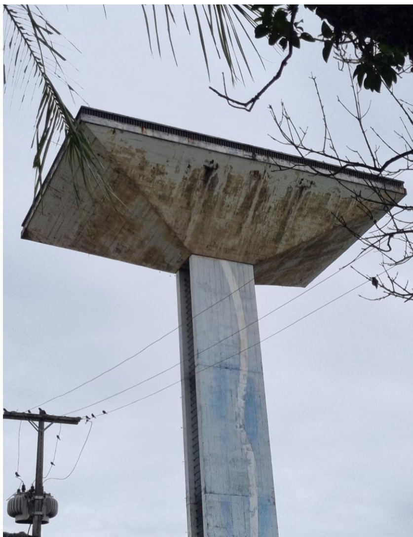
Figura 37 - Torre d'água de Rolândia
