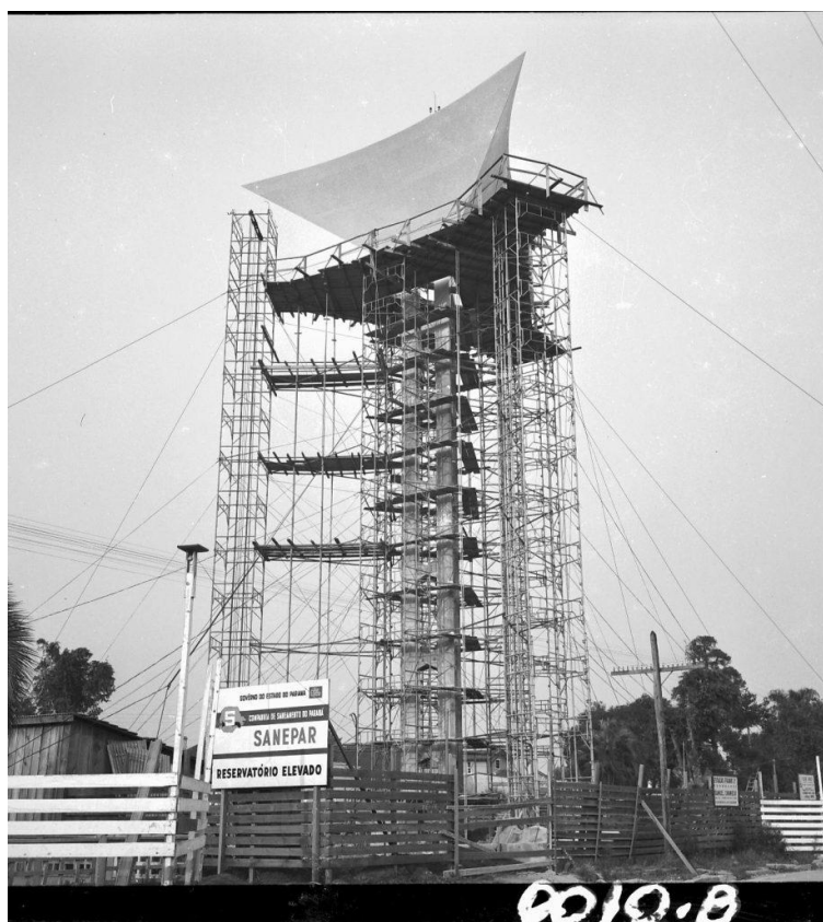
Figura 68 - Obra da Torre d'água de São José dos Pinhais
