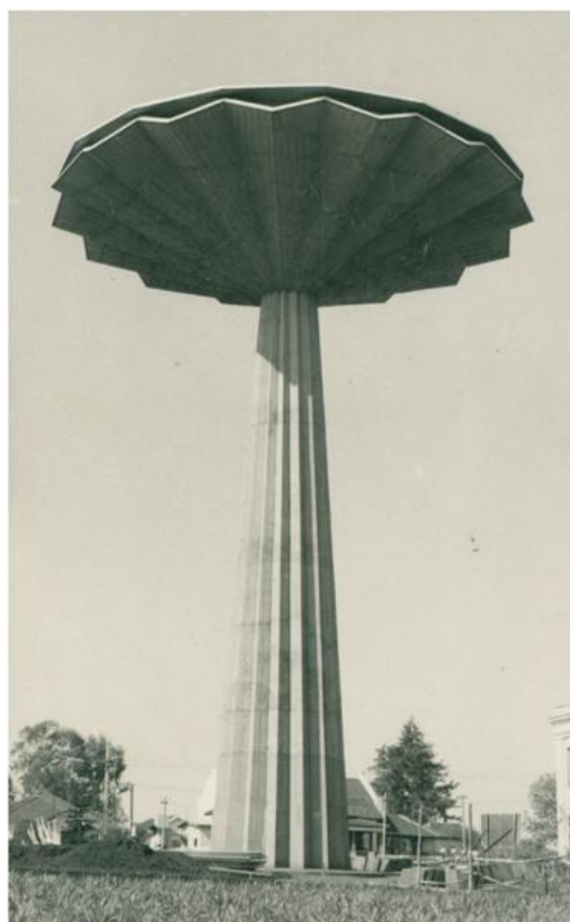
Figura 51 - Torre d'água de Arapongas
