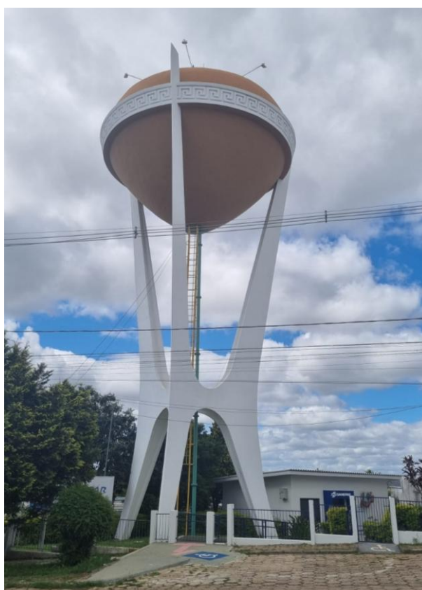
Figura 71 - Torre d'água de São Mateus do Sul
