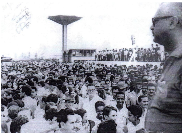
Figura 55 – Inauguração da torre d'água de Maringá
