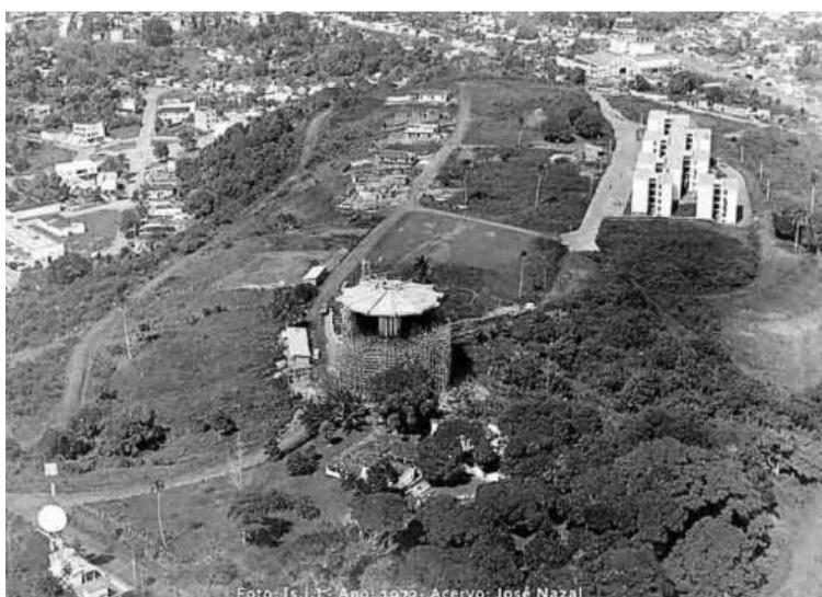
Figura 105 - Obra da Torre d'água de Ilhéus
