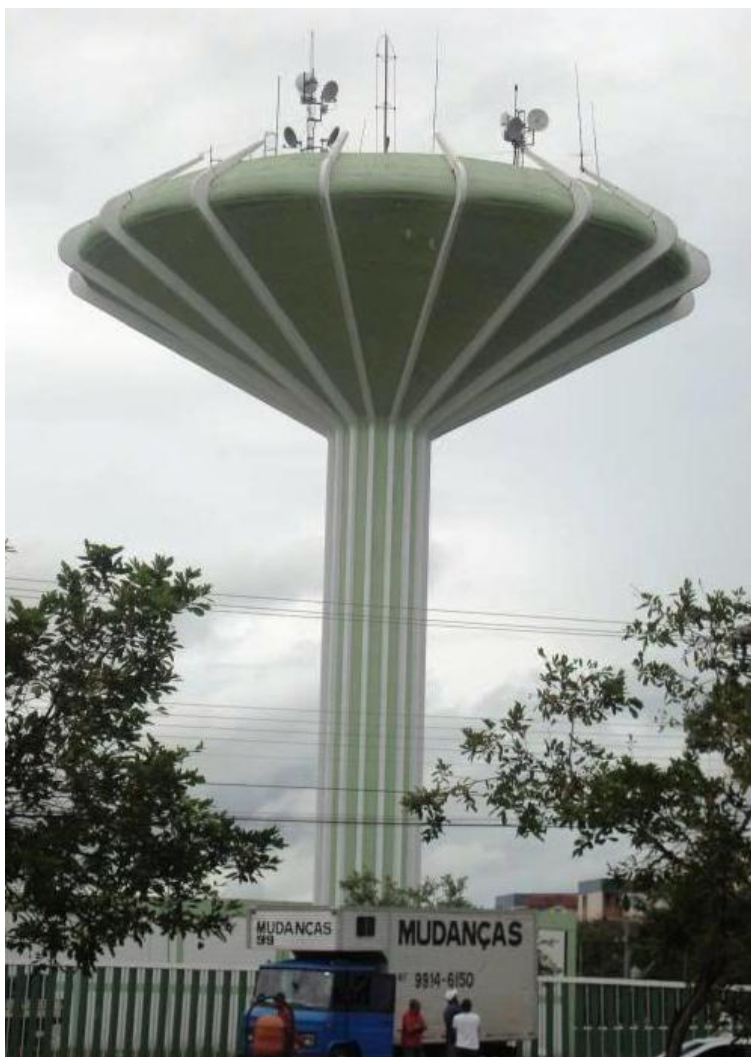
Figura 110 - Torre d'água de Ceilândia
