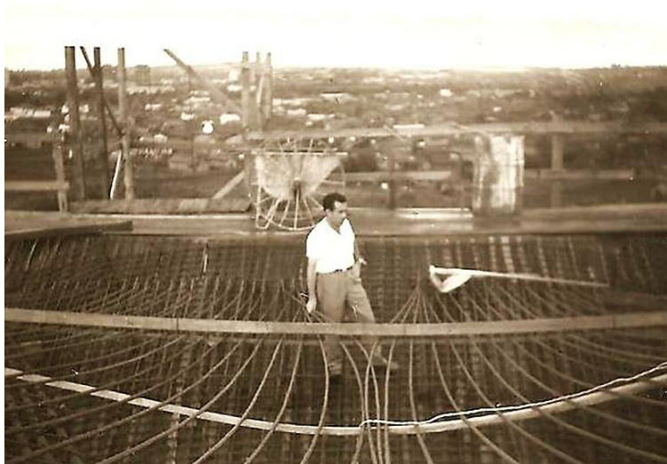
Figura 61 - Obra da Torre d'água de Maringá
