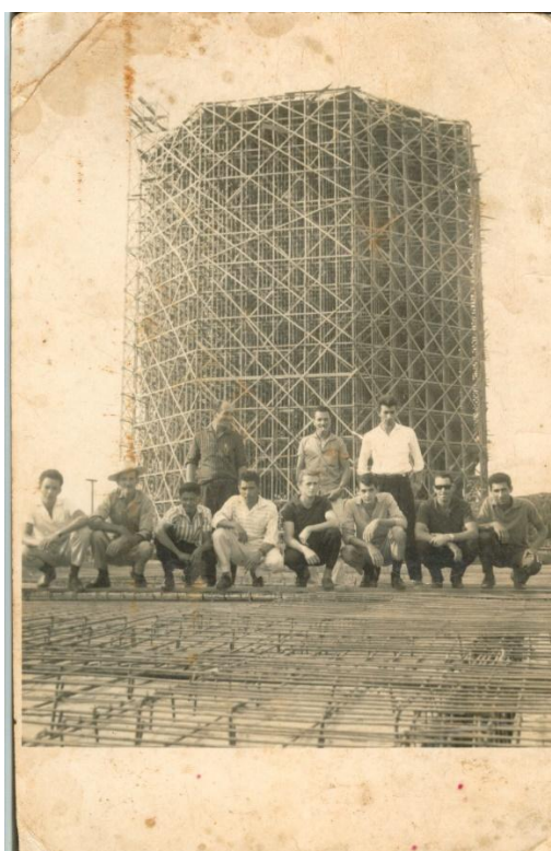
Figura 62 - Obra da Torre d'água de Maringá
