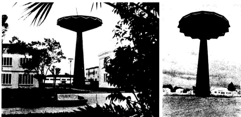
Figura 49 - Torre d'água de Arapongas
