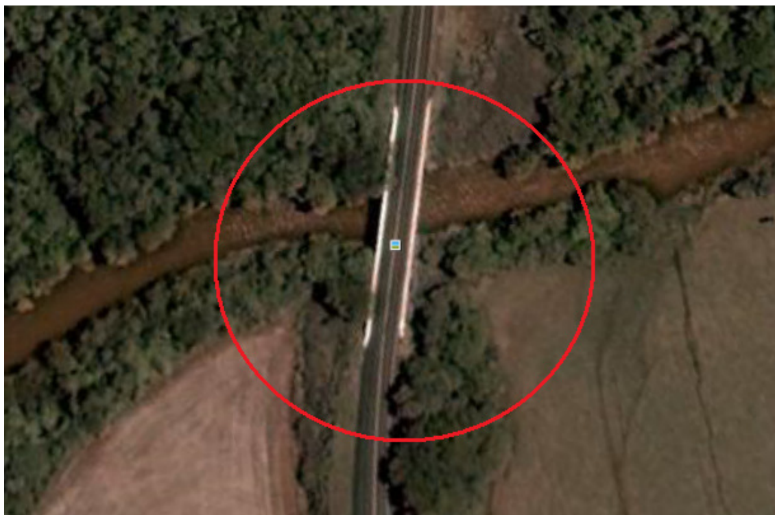
Figura 43: Ponte sobre o Rio Taquara, na PR-445 (FONTE: Google Earth).
