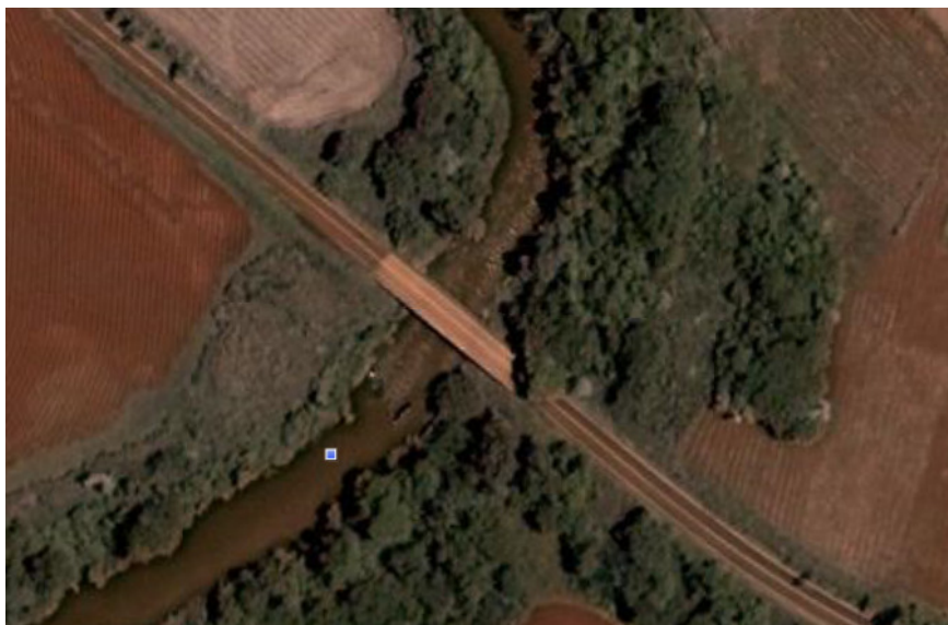
Figura 33: Localização do Rio Taquara e a ponte supracitada, próximo a Guaravera. (FONTE: Google Earth).
