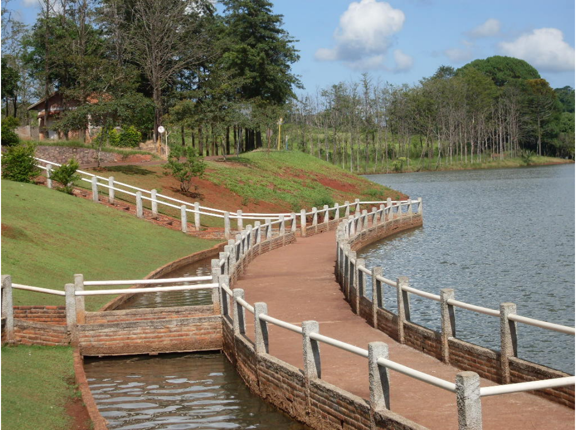
Figura 19: Infraestrutura encontrada no Parque Ecológico da Raposa no município de Apucarana, PR. (Foto: DELGADO, 2009).
