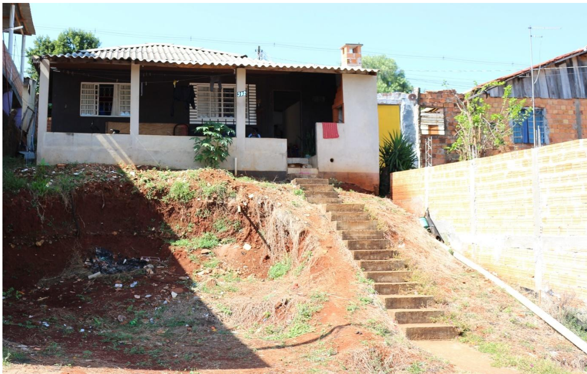
Figura 13: Casa 2- PMCMV após realização de aplicação, 2022
