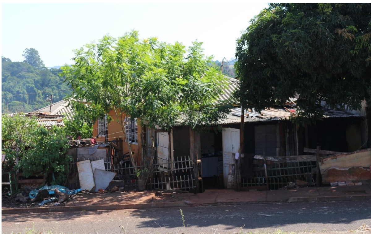
Figura 12: Casa 2 - PMCMV após realização de aplicação, 2022
