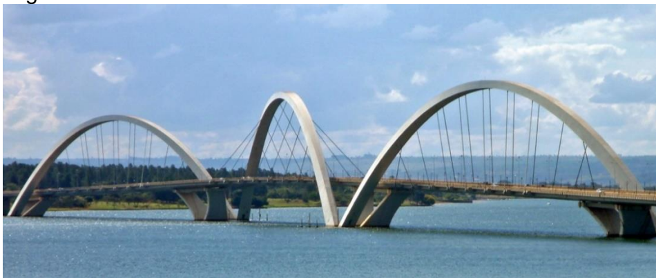
Figura 5.8 - Ponte Juscelino Kubitschek - Brasília
