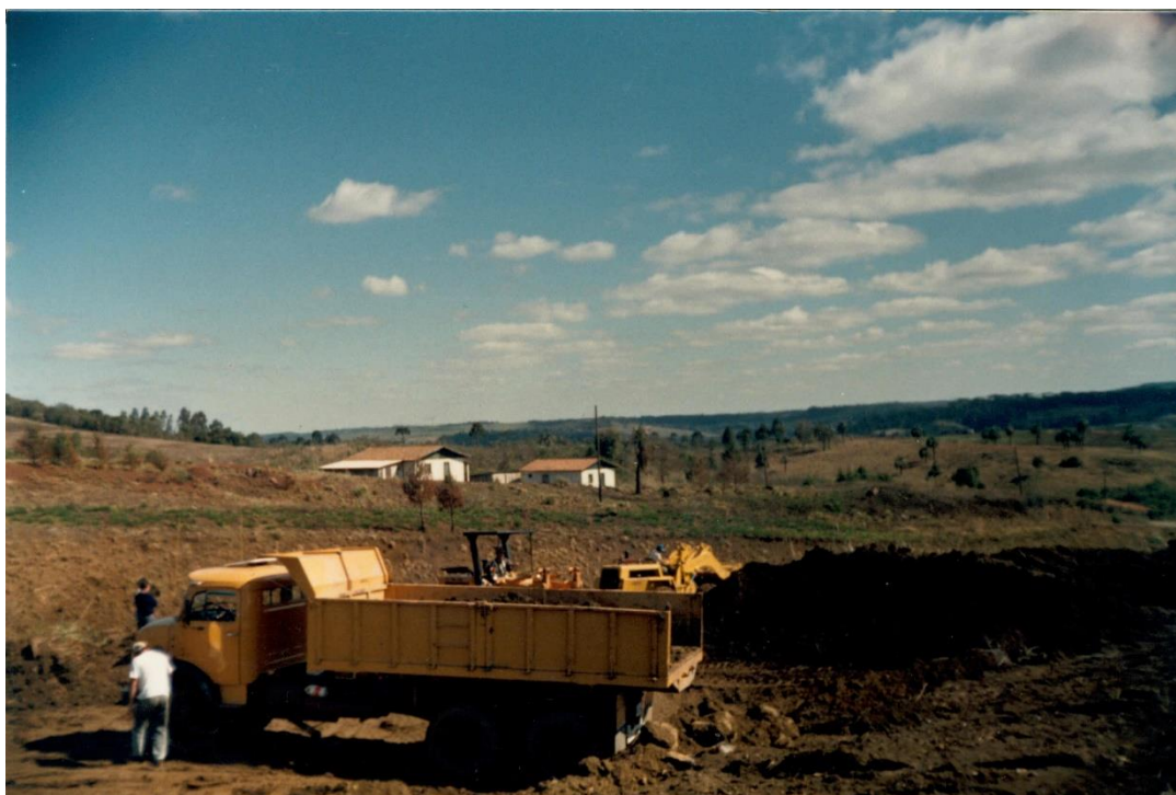
FIGURA 14: Terraplanagem do terreno do bairro Núcleo Rio Doce.
