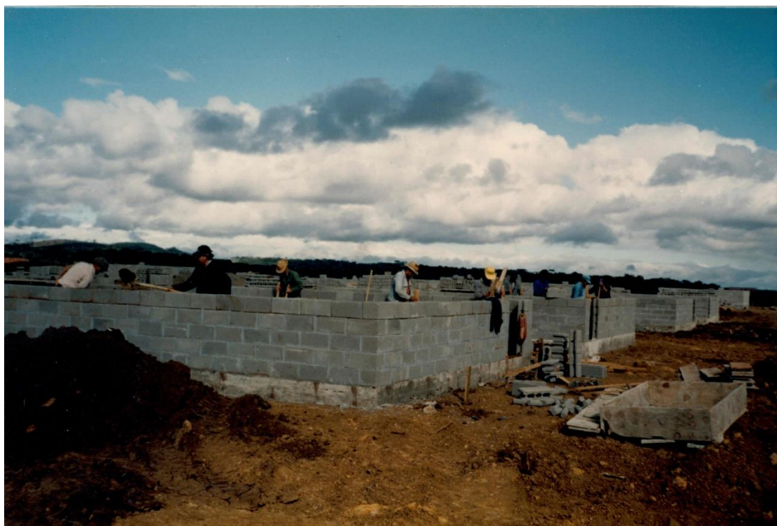
FIGURA 15: Primeiras casas construídas no bairro Núcleo Rio Doce.
