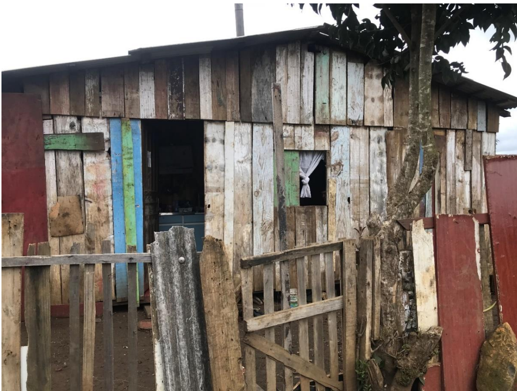
FIGURA 18: Residência no bairro Núcleo Rio Doce.
