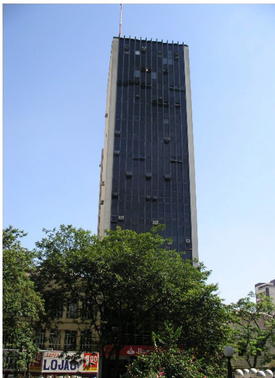
Foto 8 - Edifício Sul Brasileiro
