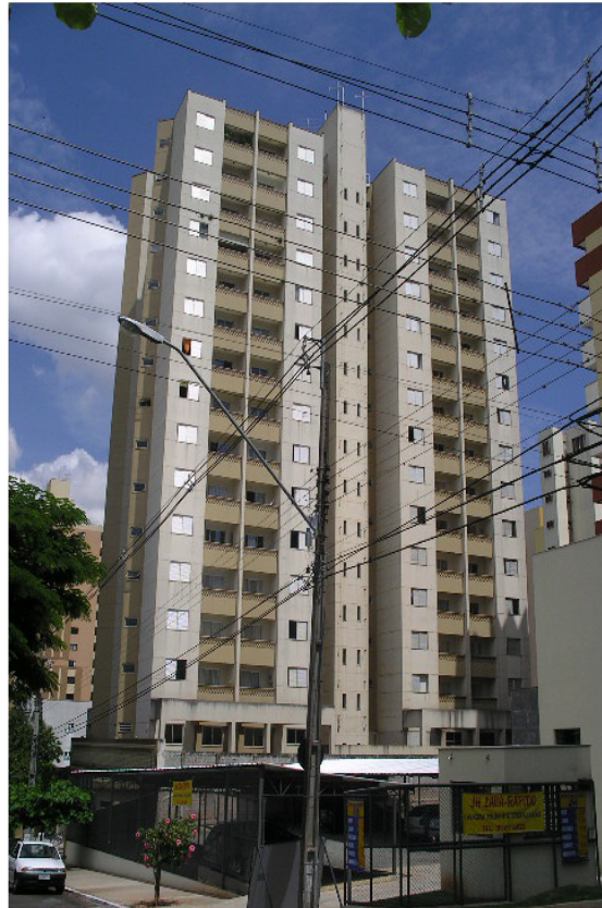
Foto 32 - Edifício Castelo Forte
