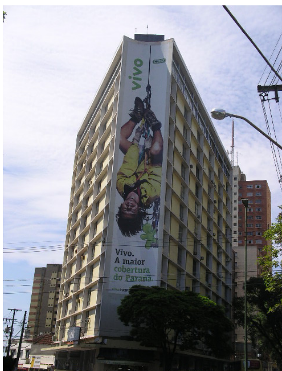
Foto 13 - Edifício Júlio Fuganti
