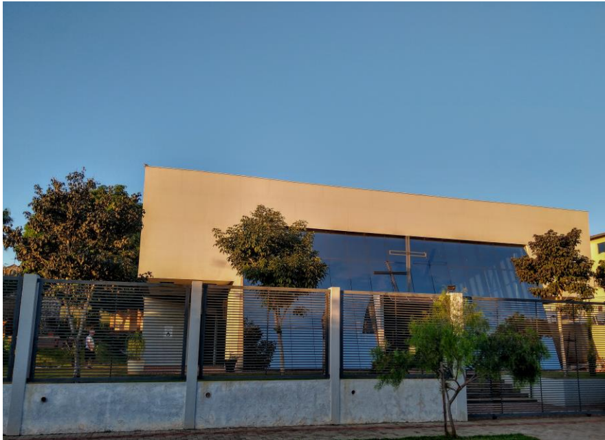
Fachada externa da Igreja Nossa Senhora do Silêncio Fonte: Arquivo pessoal
