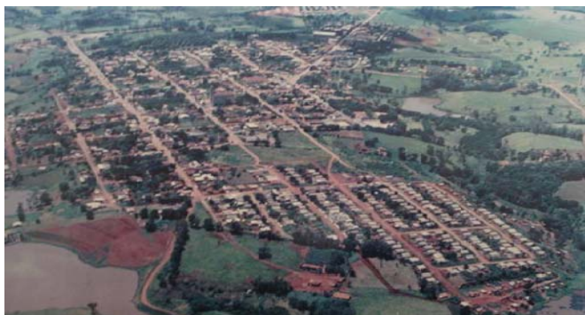
Figura 16 - Vista aérea da área urbana de Congoinhas
