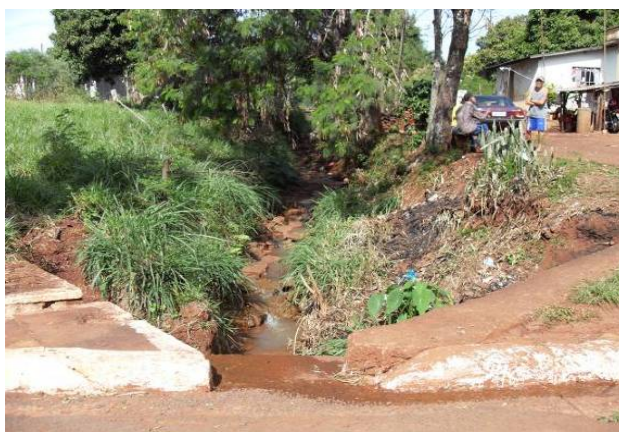
Figura 3 - Vista do Córrego da Fraternidade – Assentamento às Margens do Rio
