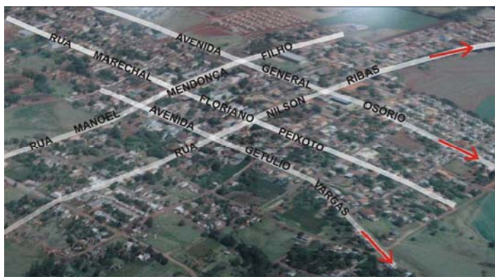
Figura 12 - Vista aérea das vias públicas pavimentadas de SCP
