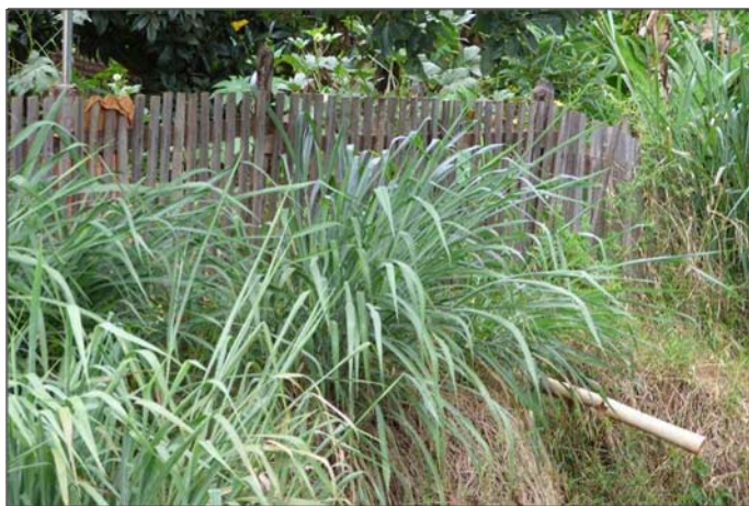
Figura 23 - Destaque para encanamento aparente fazendo o Lançamento de esgoto no córrego Lajeado
