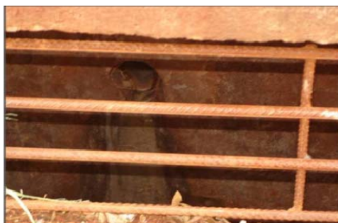
Figura 14 - Visualização do encanamento que faz a ligação do esgoto à rede de Drenagem pluvial
