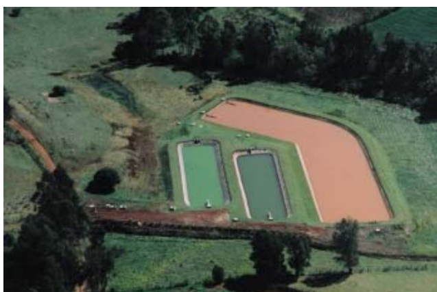
Figura 7 - Foto Aérea da Estação de Tratamento – SAMAE SCP Fonte: http://www.samaescp.com.br/
