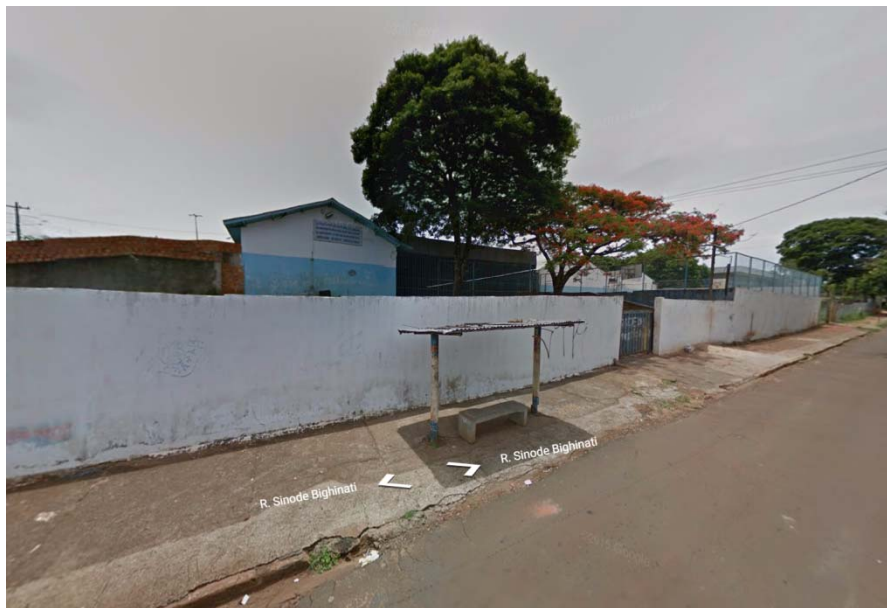
Figura 7 – Faixada da escola
